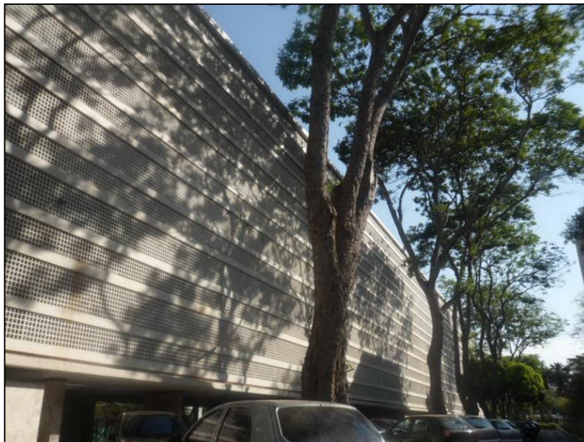
Figura 46: Edifícios com proteção arbórea contra o sol na fachada Oeste na 308 sul. Fonte: Imagem produzida pela autora
