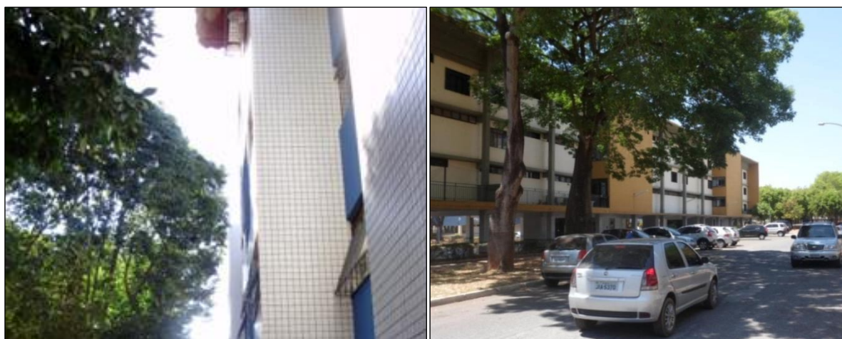
Figuras 70 e 71: Conflitos entre copa e edificação, e entre copa e sistema viário (respectivamente) na 408 Norte.
