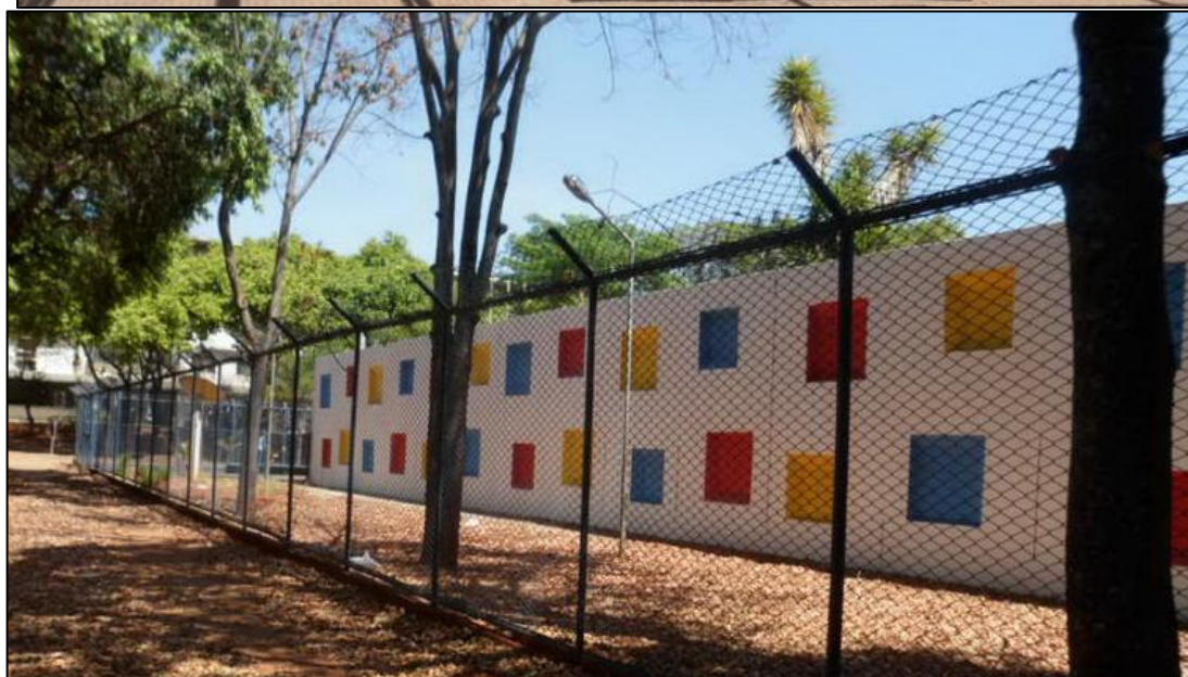
Figuras 89 e 90: Painéis artísticos na fachada da escola da 408 norte Fonte: Fotos da autora
