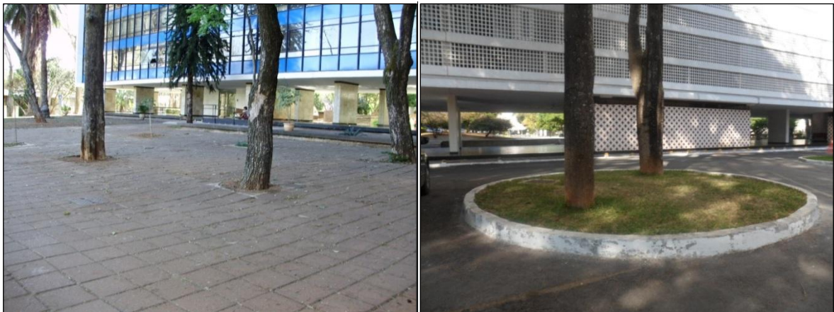
Figuras 75 e 76: Calçada e via sem danos causados pelo sistema radicular na 308 Sul. Fonte: Foto da autora.
