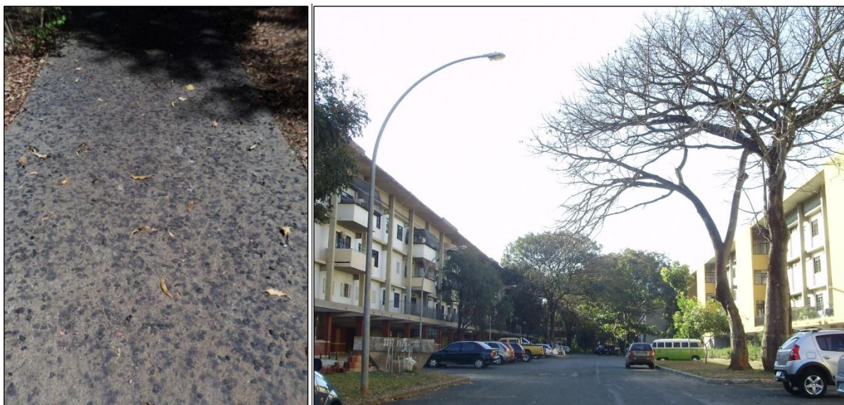
Figura 77 e 78: Calçada suja por frutas e estacionamento com árvores caducas na 408 Norte. Fonte: Foto da autora.
