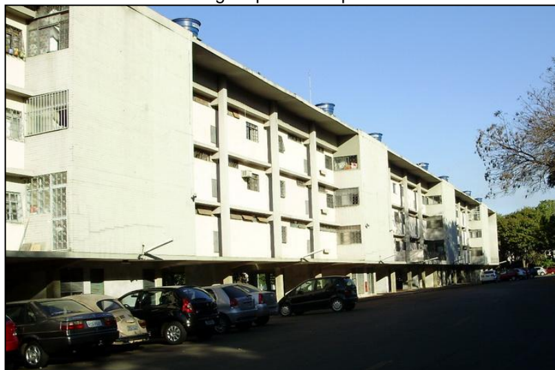
Figura 44: Edifícios sem proteção arbórea contra o sol na fachada Oeste na 408 norte. Fonte: Imagem produzida pela autora
