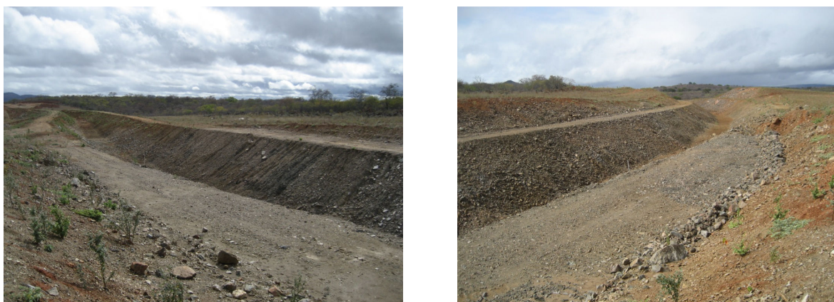
Figura 16 –Fotos da obra do canal da transposição do Rio São Francisco dentro do território da comunidade quilombola de Santana
