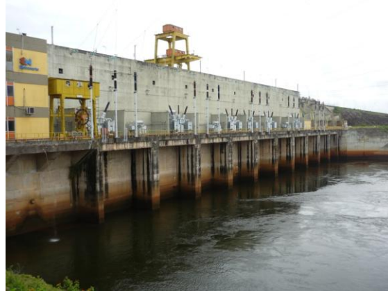
Figura 5.1 – Vista frontal da usina hidrelétrica de Balbina
