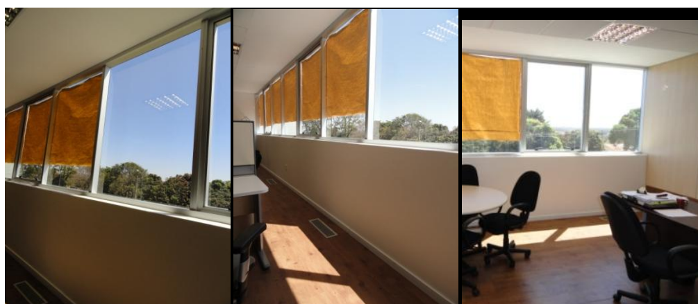
Figura 33. Janelas (vista interna).
