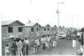
Construção das casas da QNM
