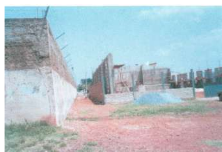
Corredor de muros cegos na entrequadra
