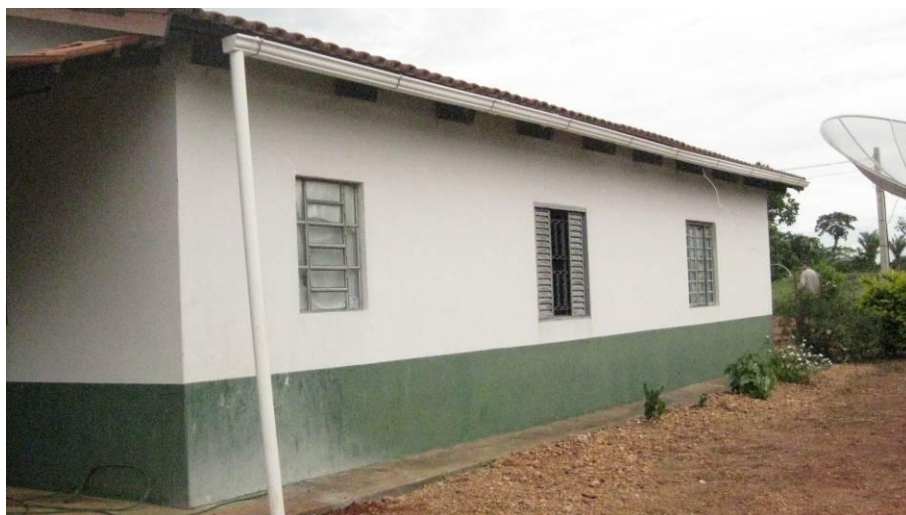
Figura 2.3 – Vista geral das estruturas de captação de água de chuva.
