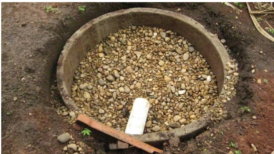
Figura 2.2 - Detalhe do preenchimento com cascalho lavado.
