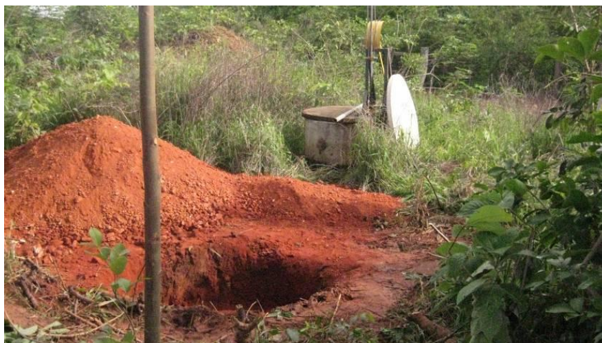
Figura 2.6 - Avaliação expedita do solo e do saprolito durante a instalação das caixas de recarga.
