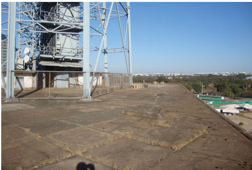
Figura 120 – Detalhe da Laje da Cobertura do Restaurante (Fonte: Autor)
