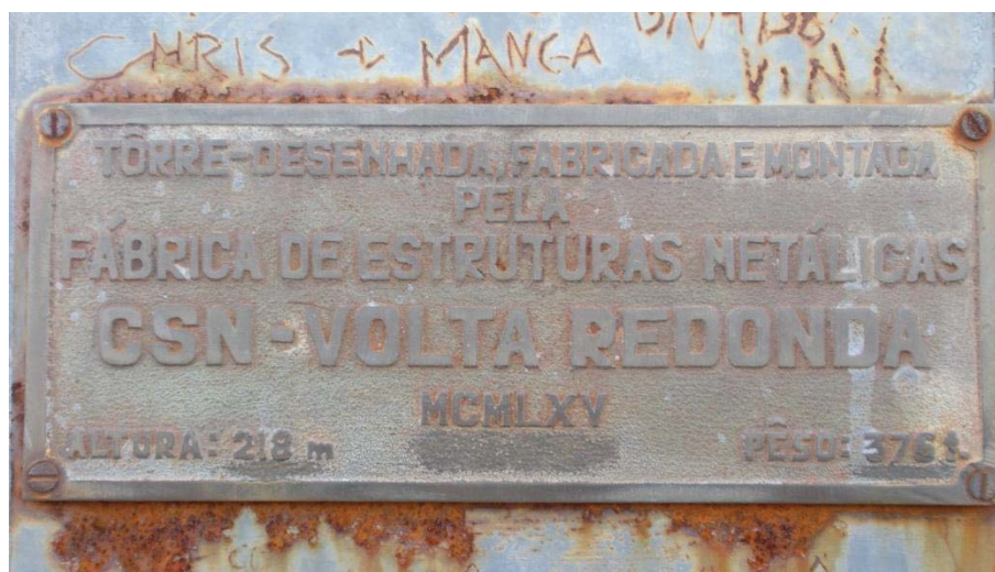
Figura 88 – Placa Comemorativa do Fim da Montagem da Torre (Fonte: Autor)
