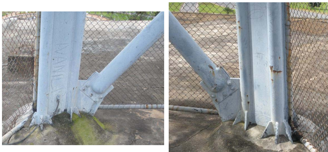
Figura 122 – Detalhe do Aparelho de Apoio das Cordas Principais na Laje de Cobertura do Restaurante (Fonte: Autor)
