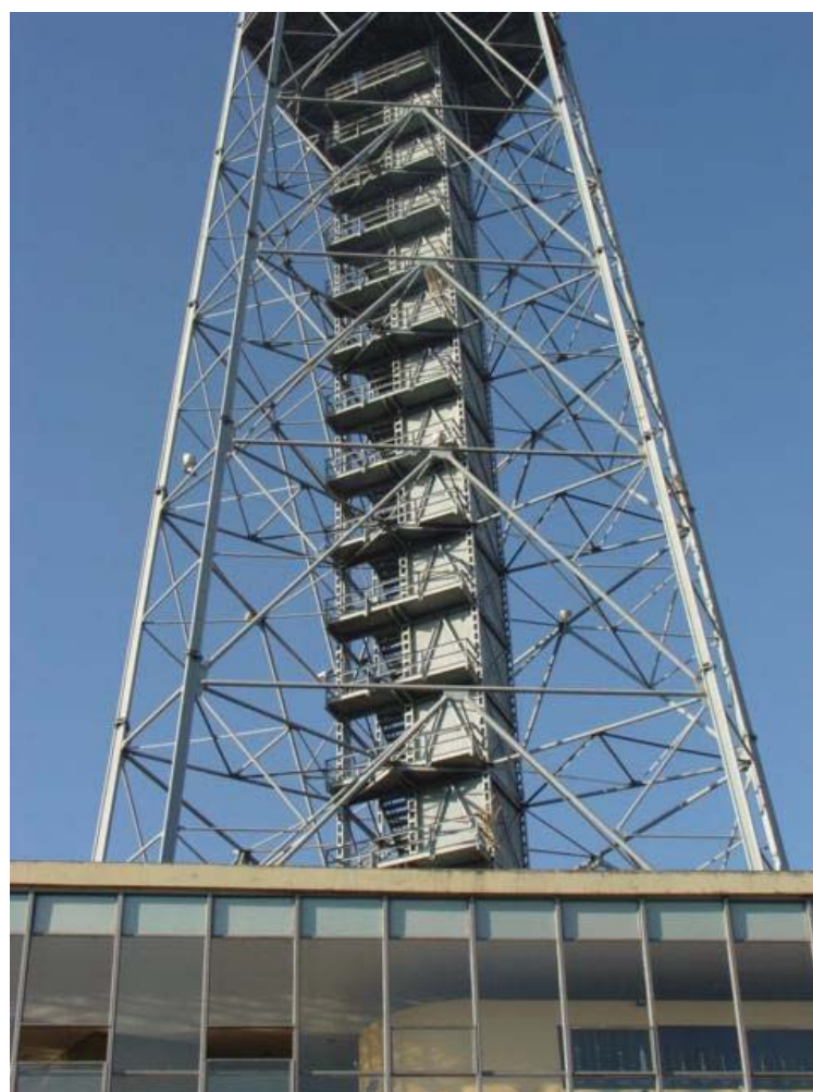
Figura 123 – Vista do Trecho I da Estrutura Metálica (Fonte: Autor)
