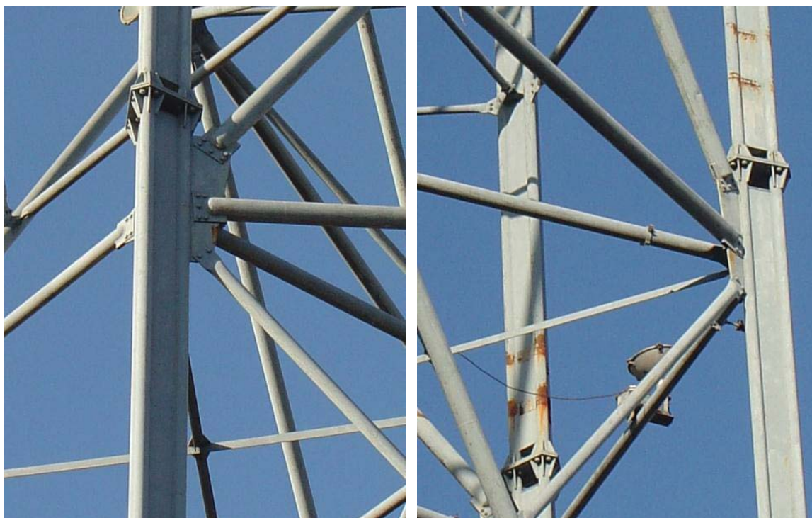
Figura 124 – Detalhes das Ligações no Trecho I (Fonte: Autor)
