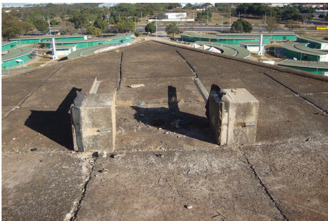
Figura 121 – Detalhe da Laje da Cobertura do Restaurante (Fonte: Autor)
