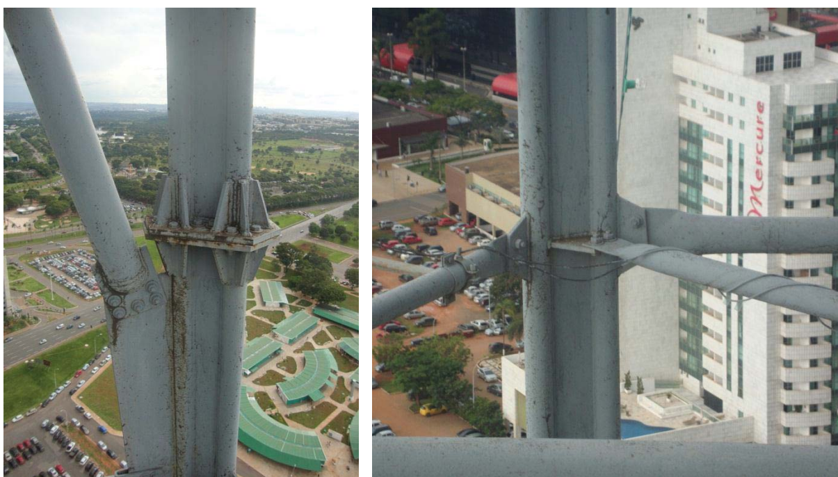
Figura 126 – Detalhes das Ligações no Trecho I (Fonte: Autor)
