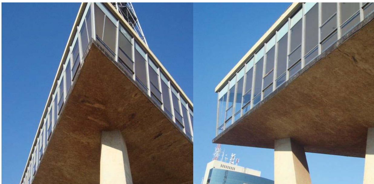
Figura 118 – Vista do fundo da laje do pavimento superior (Fonte: Autor)
