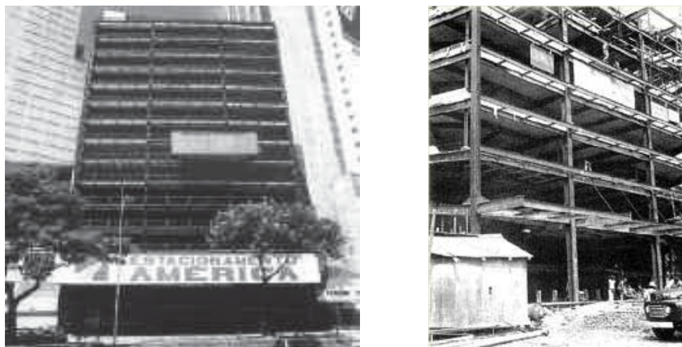
Figura 38 – Edifício Garagem América (Andrade, 1999)
