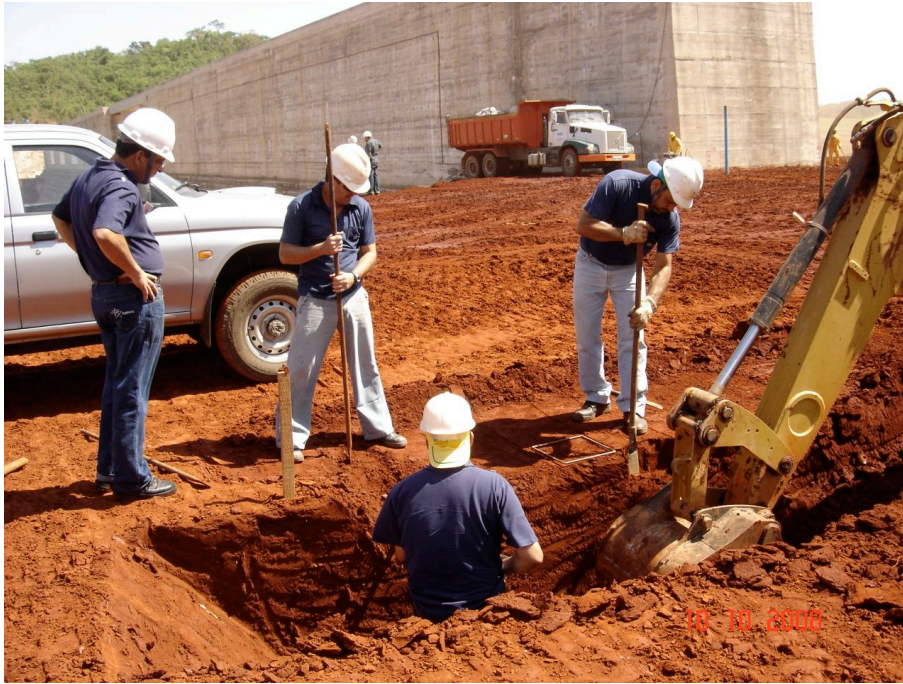
Figura 3.6 - Retirada de amostra deformada nas imediações dos blocos.
