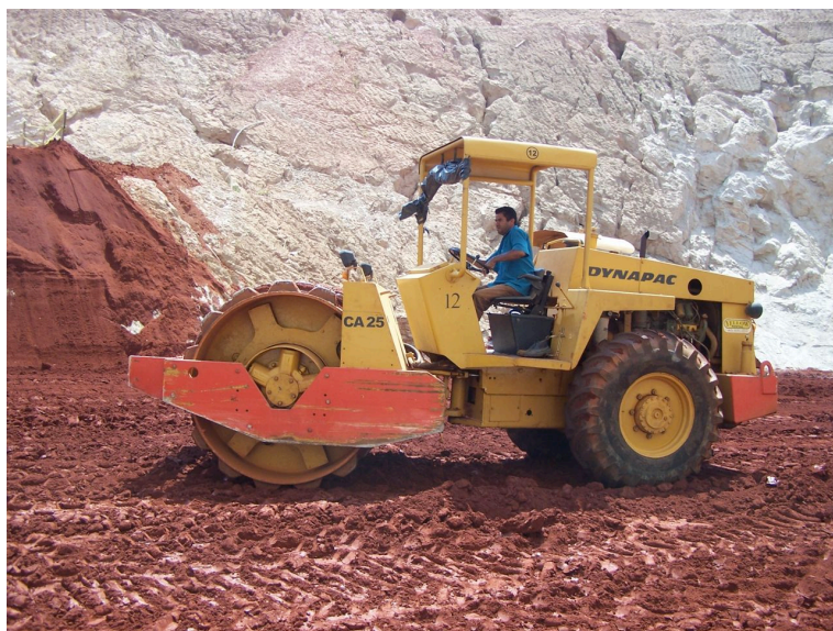
Figura 3.18 - Equipamentos de compactação utilizados: a) TC-18; b) VAP-70 e c) CA-25.
