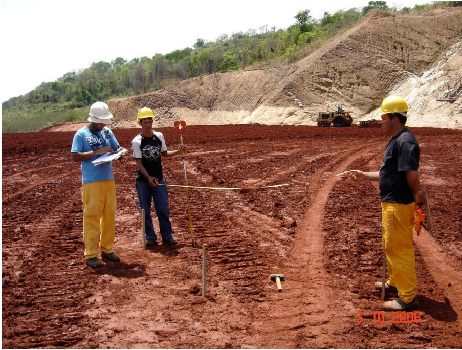
Figura 3.4 - Locação dos piquetes de alinhamento da trincheira.
