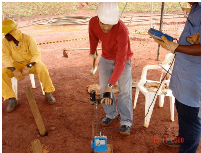
Figura 2.9 – Ensaio de Penetração Dinâmica de Cone Leve Tipo PANDA 2.
