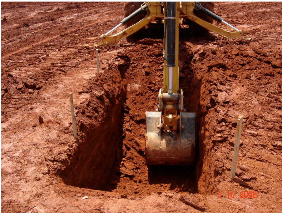
Figura 3.5 - Escavação da trincheira.
