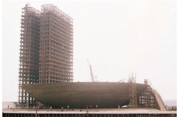
iv ) Cúpulas concretadas e torres anexas ao fundo
