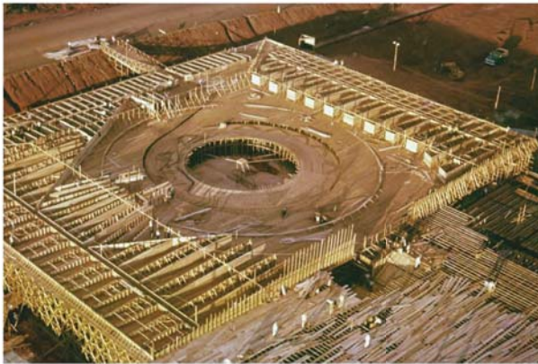
i ) Edifício Principal, início da construção
