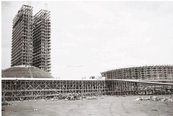
iii ) Cúpulas e esqueleto estrutural das torres
