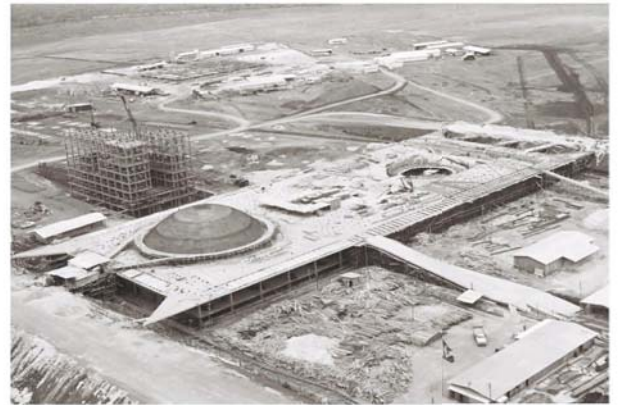
ii ) Cúpula do Senado e início das estruturas metálicas
