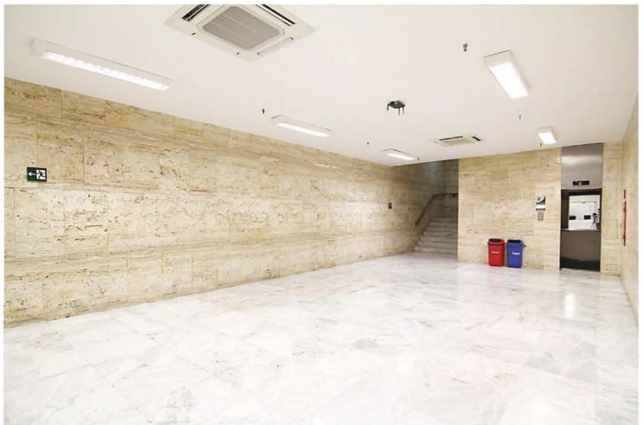
Figura 83.e Hall do subsolo Mármore travertino nas paredes e mármore branco no piso Fotografia, Elcio Gomes, 2011
