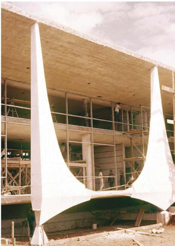
iii) Trecho da coluna em concreto e revestimento
