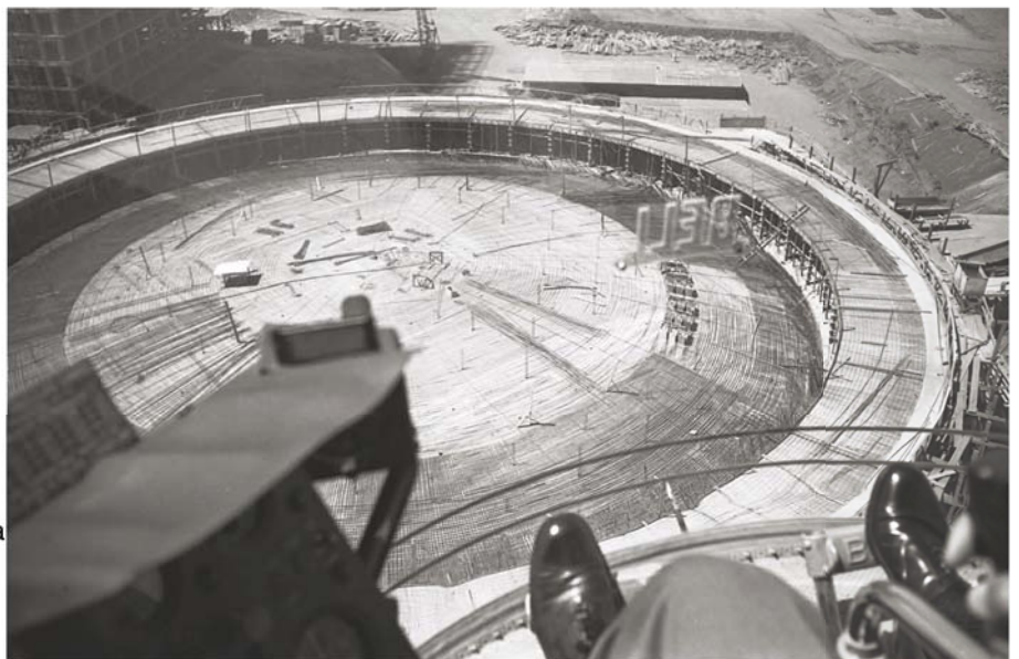
iii) Câmara - posicionamento das barras de aço
