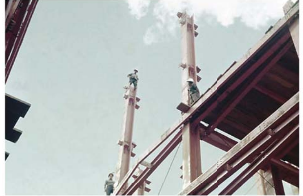
ii) Montagem do esqueleto estrutural
