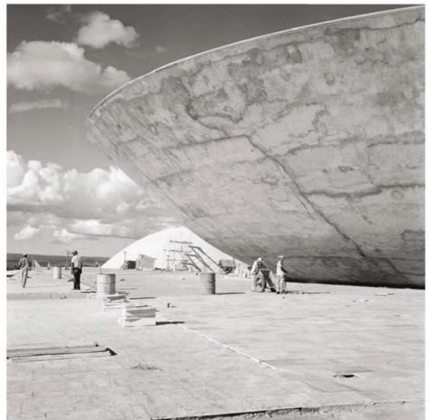
iv) Câmara - vista externa após a concretagem
