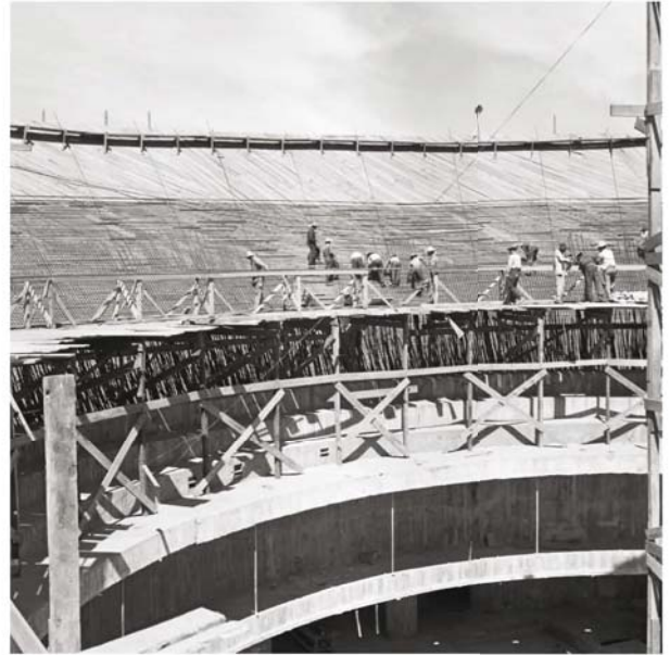
ii) Câmara - vista interna e armação para concretagem
