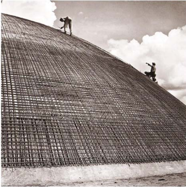
i) Senado - anel de base concretado e armação da cúpula
