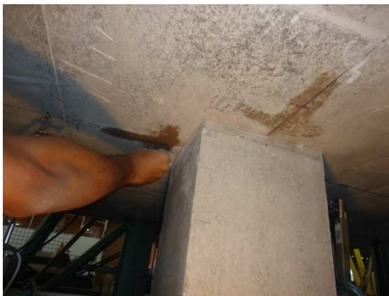
Figura 3.8.20 - Limpeza da superfície do concreto para colagem do extensômetro
