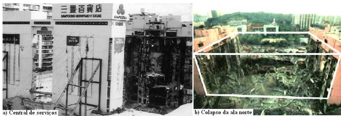
Figura 2.3.4 - Colapso do departamento de loja em Shampoong, na Coréia do Sul (GARDNER et. al., 2002)
