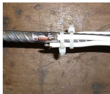
Figura 3.8.5 - Barra devidamente instrumentada
