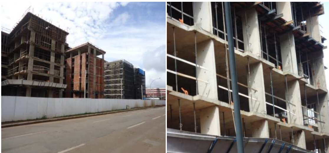
Figura 2.3.7 - Obra na Asa Sul de Brasília-DF utilizando sistema estrutural com laje lisa
