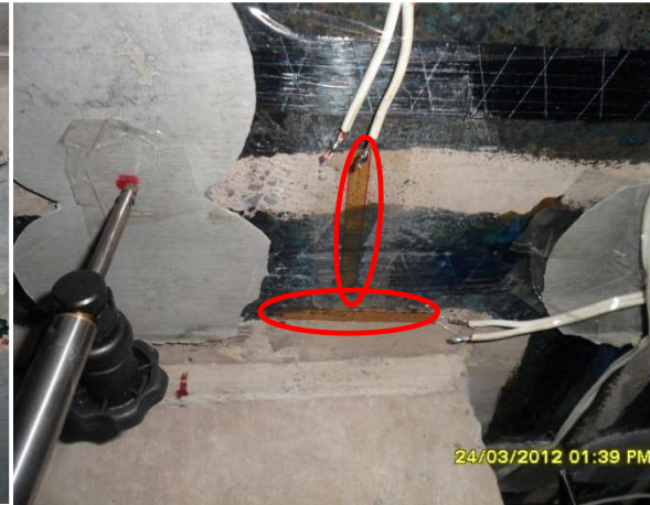
Figura 3.8.23 - Extensômetros colados na parte inferior do modelo de laje LR-S.
