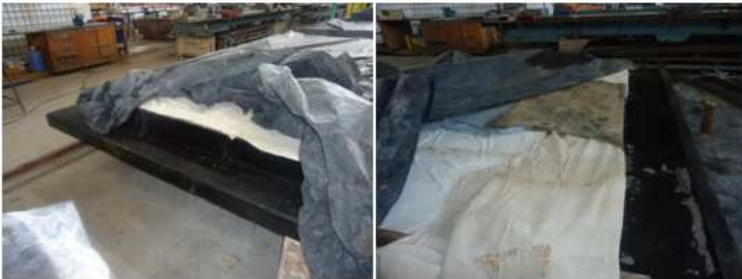
Figura 3.7.4 - Processo de cura do concreto
