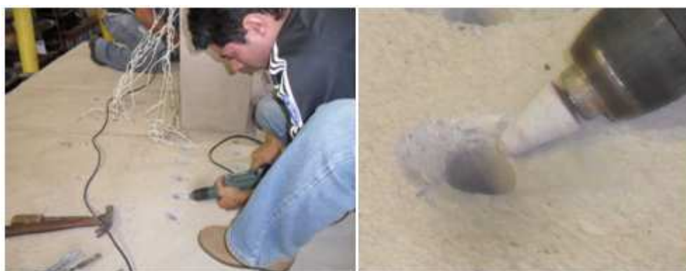
Figura 3.4.4 - Arredondamento dos cantos dos furos
