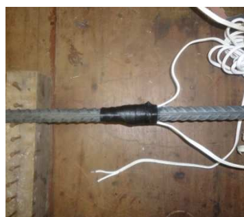
Figura 3.8.8 - Barra após aplicação da fita isolante.
