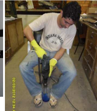
Figura 3.4.12 - Preparo do Saturant MBrace
