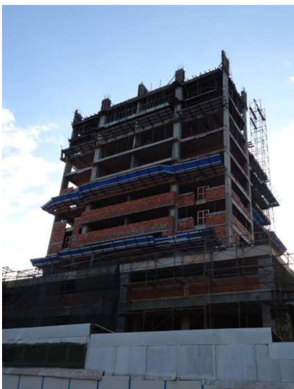
Figura 2.3.8 - Obra de 10 pavimentos em águas Claras-DF utilizando sistema estrutural com laje lisa
