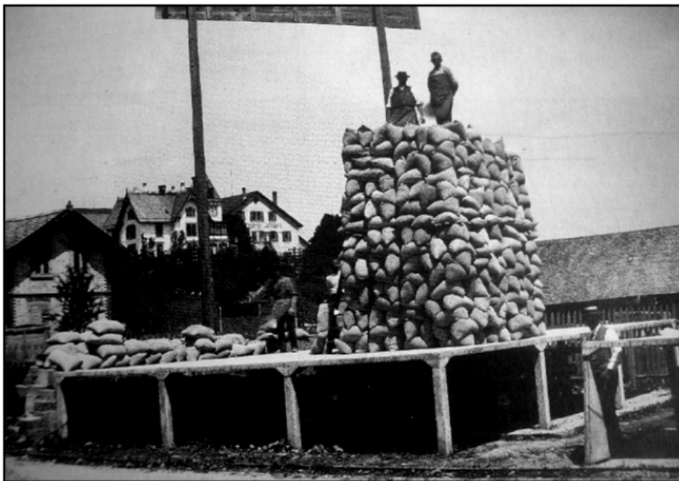
Figura 2.3.2 - Testes executados por Maillart (FERREIRA, 2010)
