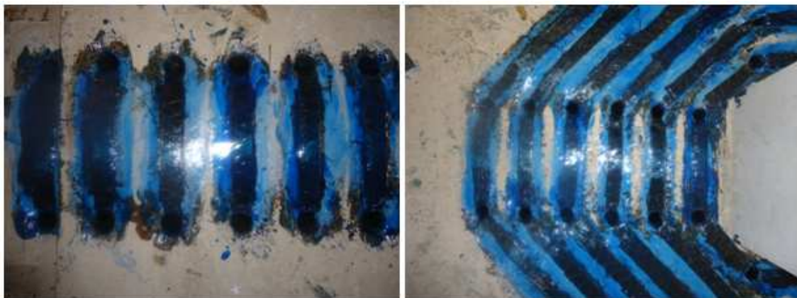
Figura 3.4.13 - Aplicação do PRFC
