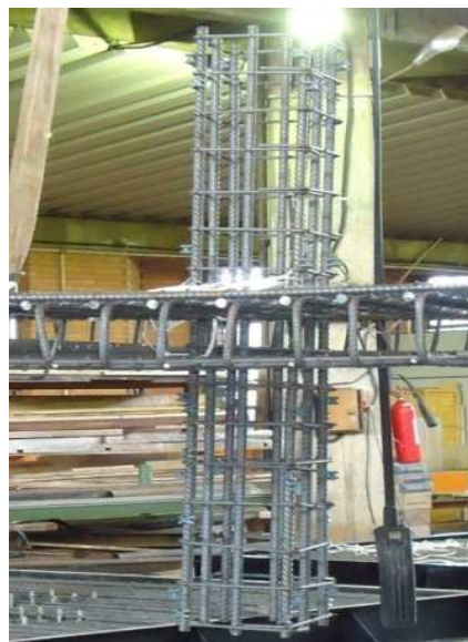
Figura 3.5.2 - Detalhe da armadura do pilar
