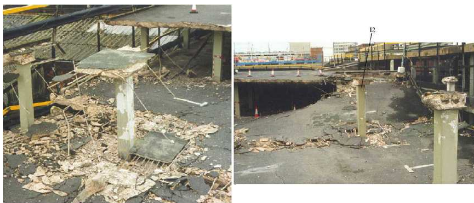
Figura 2.3.6 - Visão geral dos pilares do edifício Pipers Row Car Park, Wolvehempton-Inglaterra (WOOD, 1997)
