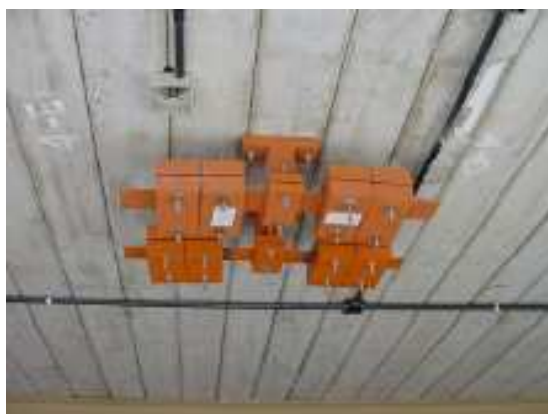
Figura 2.12. Atenuador Dinâmico Sintonizado (Battista e Varela, 2002).
