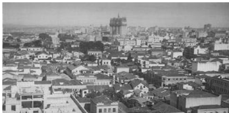
Em 1929, o primeiro arranha-céu de São Paulo, o Ed. Martinelli ainda estava em construção e já se destacava na paisagem
