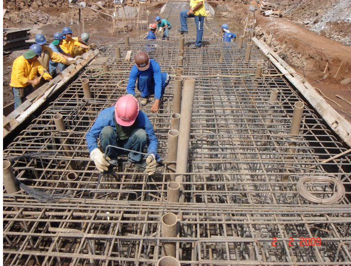
Figura 3.23 Vista da Armadura Utilizada no Plinto.
