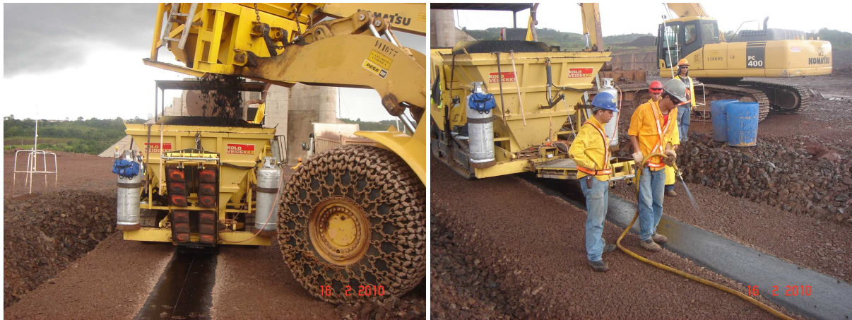
Figura 3.33 Preparação da Camada após Chuva: a) Dispositivo de Aquecimento ( Heater ), b) Secagem Utilizando o Heater e Ar Comprimido.
