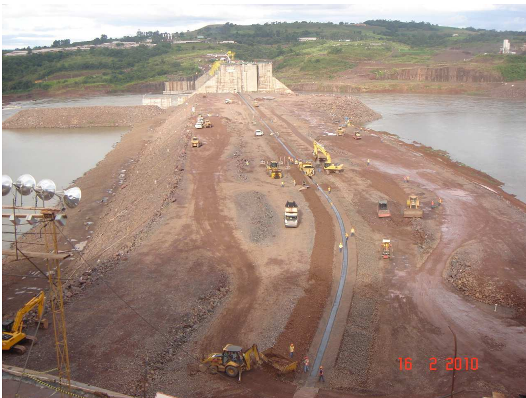
Figura 3.6 Vista da Barragem da Margem Esquerda até o Muro do Vertedouro.
