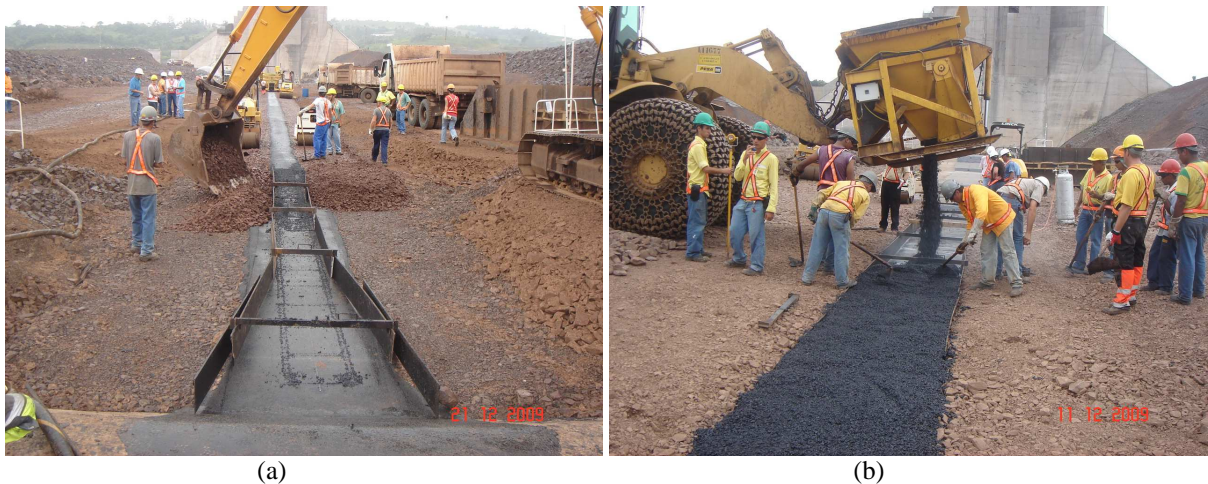
Figura 3.30 Lançamento Transição Fina e Concreto Asfáltico: a) Lançamento Transição Fina, b) Lançamento Concreto Asfáltico.
