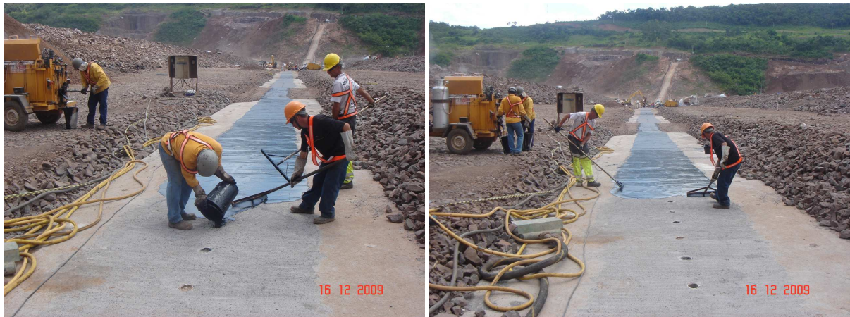
Figura 3.28 Aplicação do Mástique: a) Detalhes do Espalhamento, b) Camada de Mástique Aplicada.
