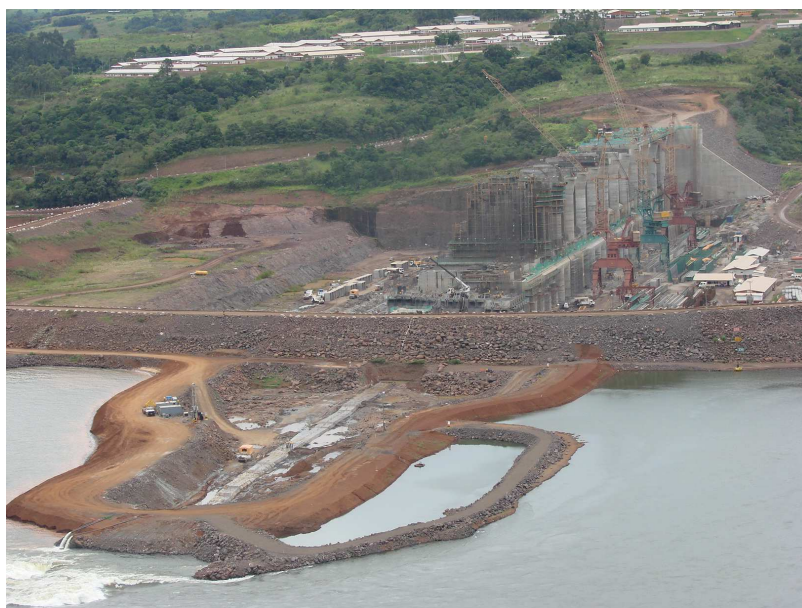
Figura 3.22 Construção do Plinto do Leito do Rio – 3ª Etapa.
