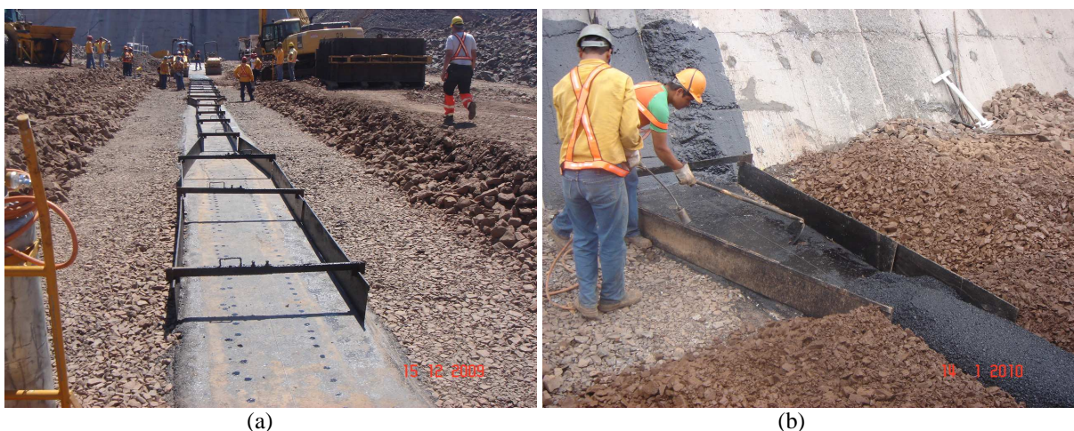
Figura 3.29 Montagem das Formas: a) Primeiras Camadas, b) Encontro com Vertedouro.
