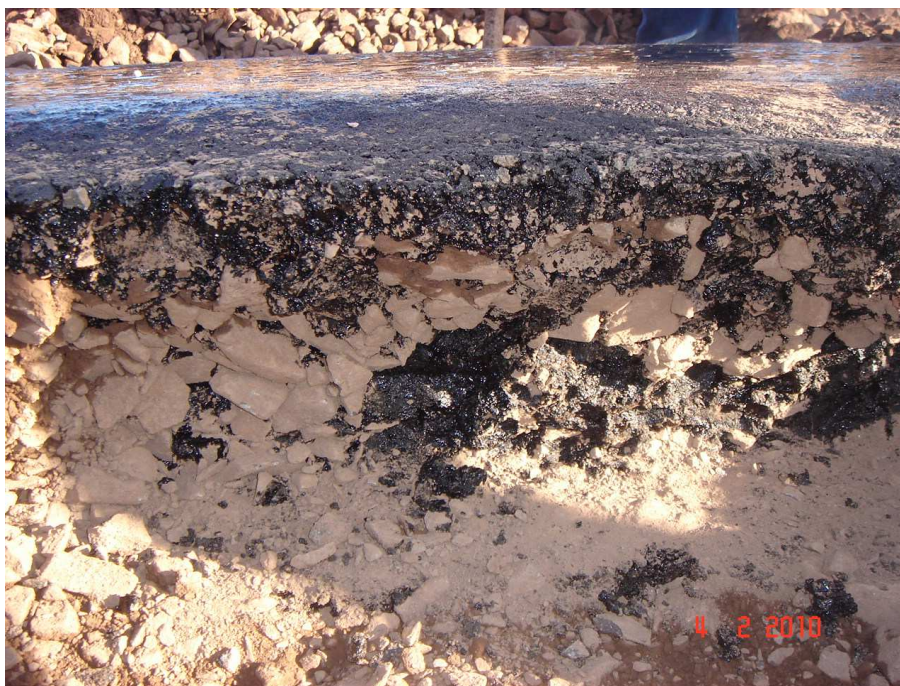
Figura 3.46 Estreitamento da Base da Camada 81.
