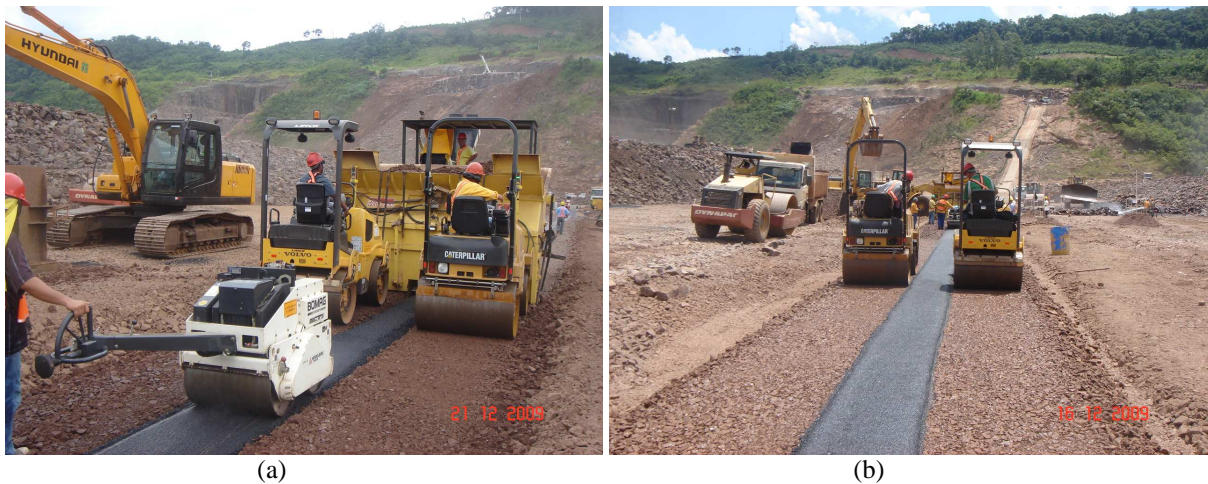
Figura 3.32 Compactação Núcleo e Transição Fina: a) Detalhes da Compactação do Núcleo e Transição Fina, b) Vista da Camada Compactada.
