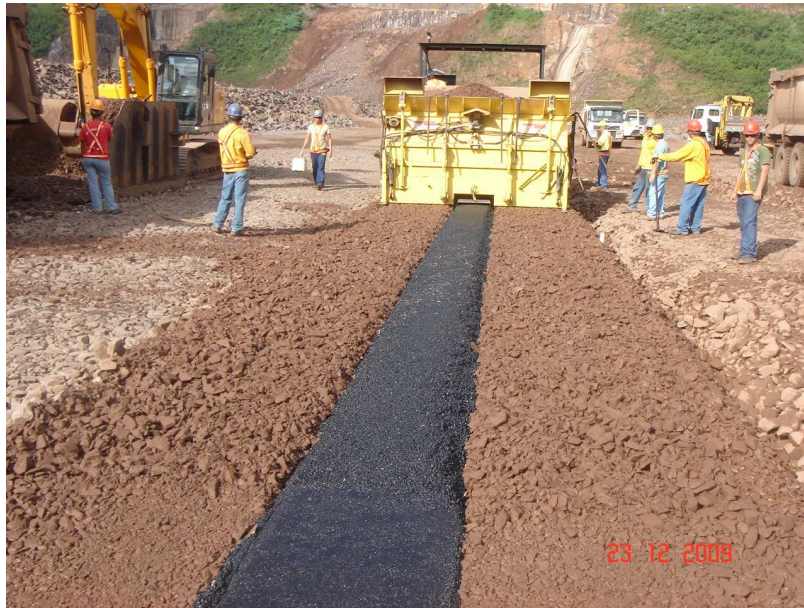
Figura 3.31 Distribuição do Concreto Asfáltico e Transição Fina.
