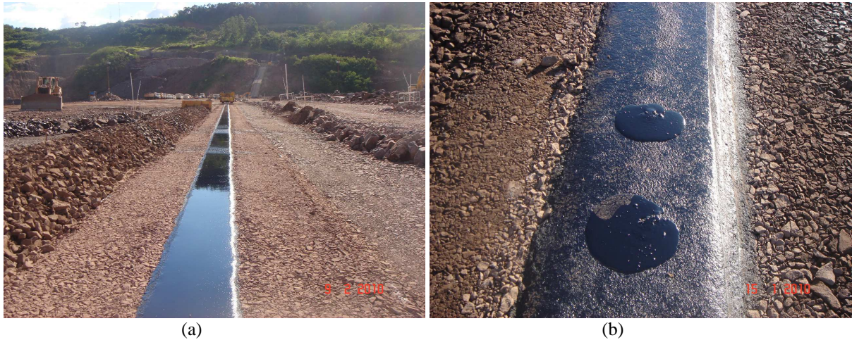
Figura 3.41 Ocorrência de Exsudação nas Camadas Após a Compactação: a) Uniforme, b) Concentrada.
