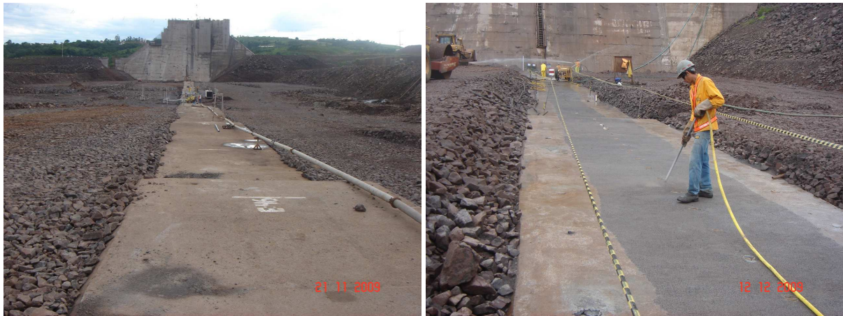
Figura 3.26 Preparação do Plinto: a) Base da Fundação Alinhada com Topo do Plinto, b) Execução da Limpeza do Plinto.
