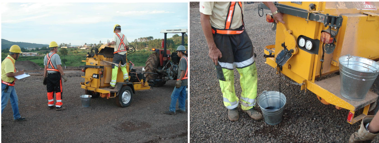
Figura 3.27 Produção do Mástique: a) Equipamento Utilizado para a Mistura do Mástique, b) Detalhe da Consistência do Mástique.
