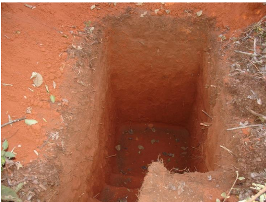
Figura 3.3 – Forma das trincheiras no campo.
