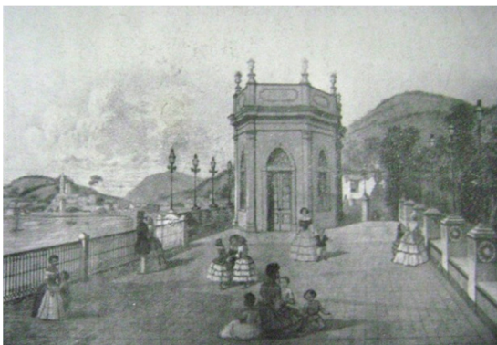
Figura 67 - Terraço antes da reforma, 1850
