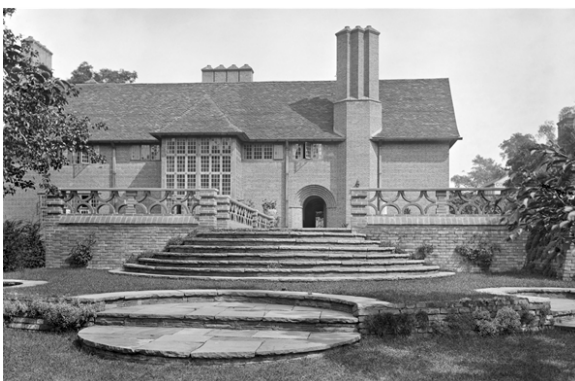
Figura 22 - Vista geral da casa
