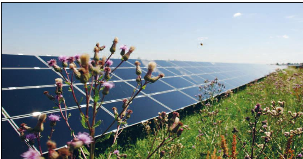
Figura 2.6 - Aplicações não domésticas não conectadas à rede - PV on Mount Fuji Japan Courtesy Izumi Kaizuka
