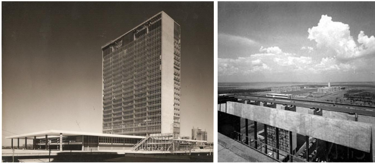
Figura 73 - Foto de vista nordeste do Sede I mostrando o vão do terraço no topo. À direita, foto da vista da Esplanada a partir do terraço do Sede I. A sala de recreação dos funcionários e a casa do zelador com a vista com as perspectivas mais privilegiadas do edifício. Fotos: M. Gautherot (1960)/Acervo IMS.
