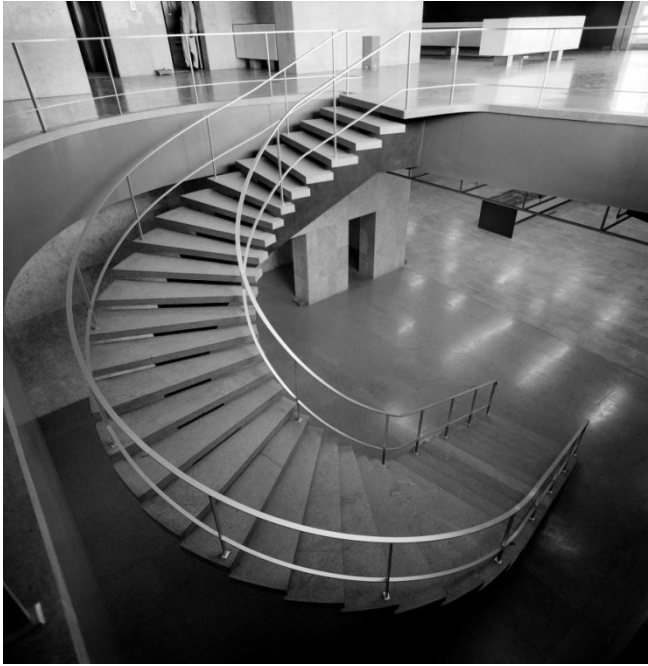
Figura 110 – Escada 2º SS – alteração do corrimão - normativos de segurança e acessibilidade demandando alterações. Fotos: à esquerda, Marcel Gautherot (1960) /Acervo IMS; à direita, JWJ (2012).
