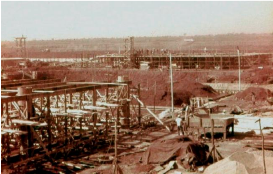
Figura 56 – Conclusão das fundações e início da estrutura. Foto: Ivo Penna, de 1959.
