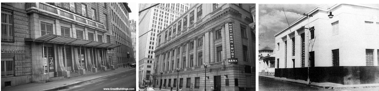
Figura 46 - A linguagem tradicional de prédio bancário. À esquerda, Banco Postal de Viena. Ao centro, Banco de Chicago, de 1905/28. À direita, Banco do Brasil de Uberlândia, de 1939. Edifícios bancários anteriores ao MTCO: esmero técnico e formal na construção porém sustentando o conceito de tradição e solidez nas formas clássicas e/ou na opacidade e materialidade dos edifícios. Fontes: Google e arquivo digital próprio.
