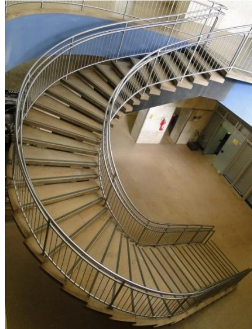
Figura 110 – Escada 2º SS – alteração do corrimão - normativos de segurança e acessibilidade demandando alterações. Fotos: à esquerda, Marcel Gautherot (1960) /Acervo IMS; à direita, JWJ (2012).
