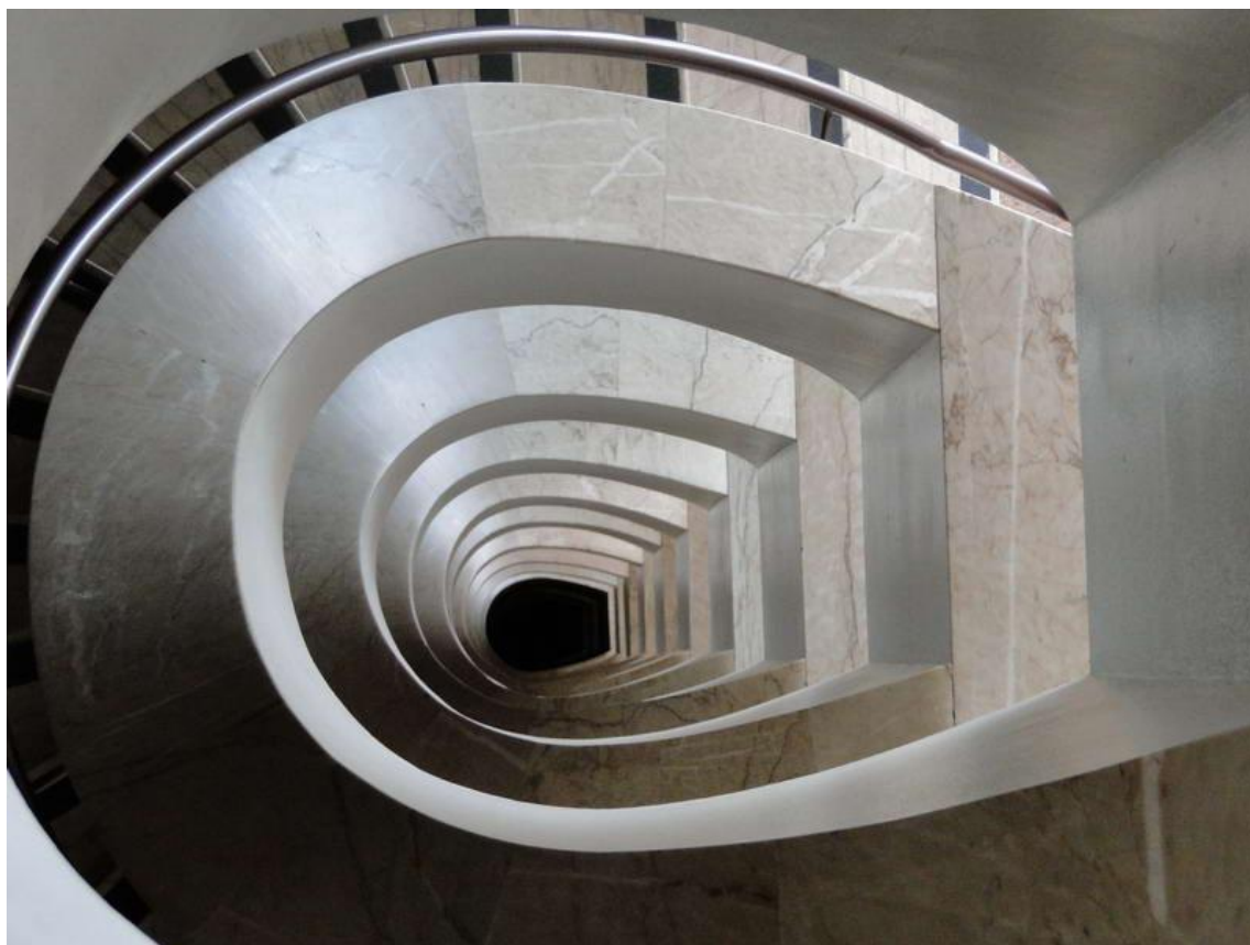
Figura 118 – Escada interna do Sede I. A riqueza discreta de detalhes e materiais dá sentido estético ao conjunto. Foto: JWL (2012).
