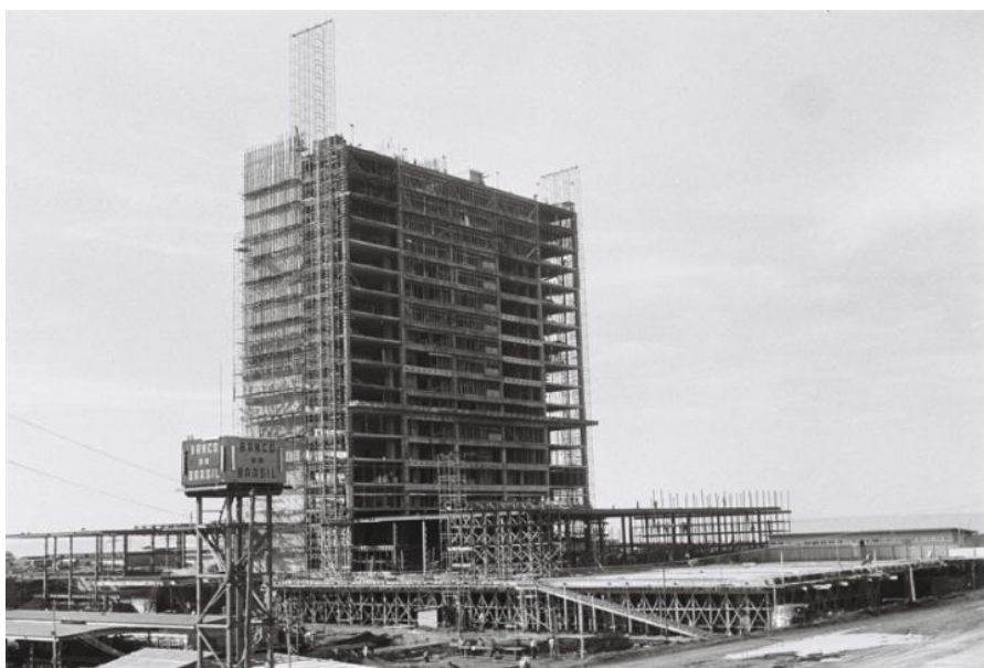
Figura 64 – Esquema estrutural da torre do Sede I - pilares ligeiramente recuados da fachada para a colocação da esquadria corrida e empenas laterais de contraventamento. Foto: Ivo Penna, 1959.
