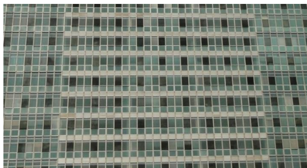
Figura 70 - Trecho de fachada envidraçada do Sede I. Foto JWL (2012).
