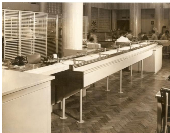
Figura 81- Esteira mecanizada para transporte de documentos no mesmo pavimento –“tecnologia integrada ao edifício”. Foto: Gautherot (1960). Fonte: arquivo de fotos da família de Garcia Roza.
