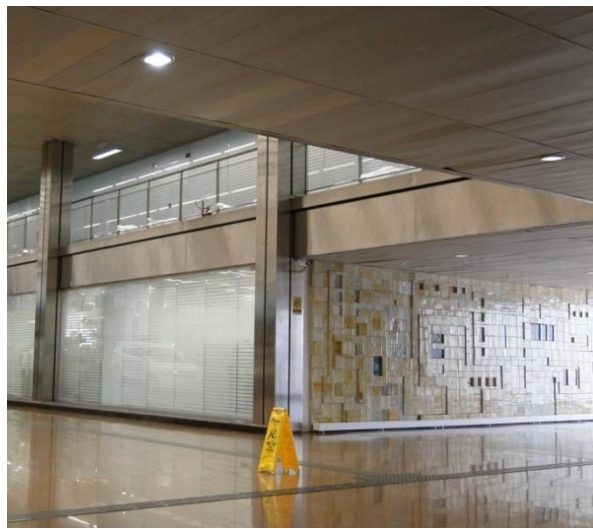
Figura 105 - Mezzanino – fechamento em vidro de alguns trechos do perímetro do térreo. Fotos Marcel Gautherot (1960)/Acervo IMS e JWL (2012).
