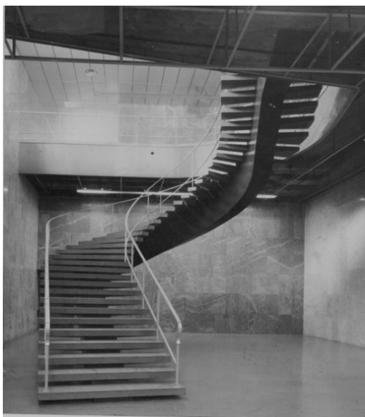
Figura 109 – Escada 2º SS – alteração do corrimão. Fotos: Marcel Gautherot (1960) /Acervo IMS e JWL (2012).
