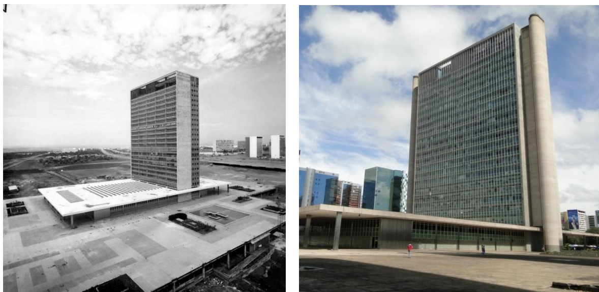
Figura 98 - Alteração na composição do edifício em função de legislação de segurança – escadas de incêndio inseridas na cortina vertical de concreto, em 1997/98. Essa é a intervenção de maior interferência na composição original do edifício, embora, a nosso ver, feita com certa parcimônia e qualidade, minimizando os prejuízos. É fácil verificar como esse tipo de intervenção pode ser desastroso observando a inserção de escada de incêndio, feita posteriormente, no edifício do BRB, de MM Roberto, no próprio SBS. Fotos: Marcel Gautherot (1960) /Acervo Instituto Moreira Salles(IMS) e JWL, 2012.
