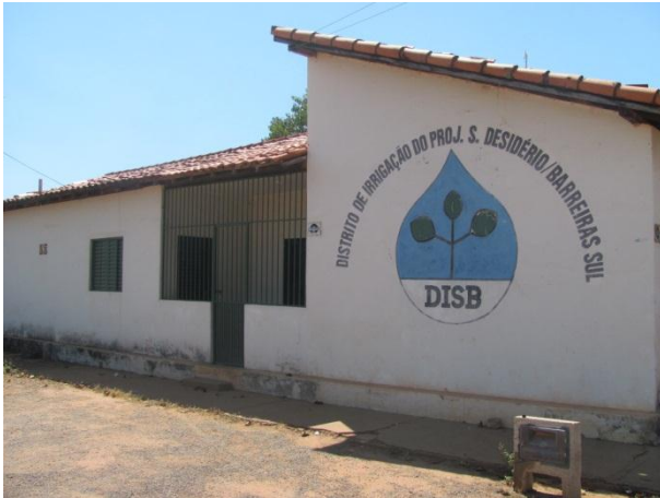
Sede do Distrito de Irrigação São Desidério/Barreiras Sul
