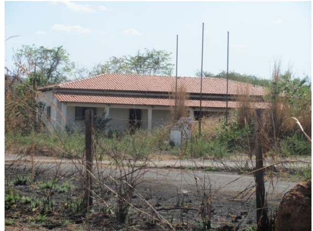
Edificação da Codevasf abandonada no Projeto Nupeba
