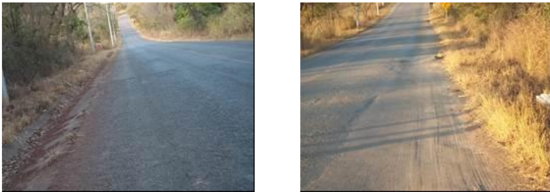
Figura 4.48 – Vista geral da drenagem da via.
