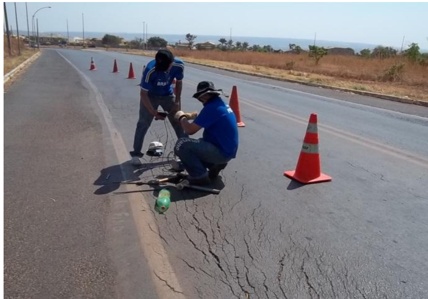
Figura 3.17 – Ensaio de PANDA no Trecho 2.
