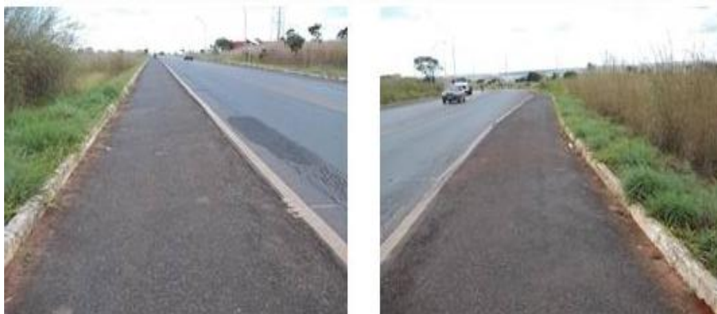
Figura 4.101 – Drenagem e acostamento.
