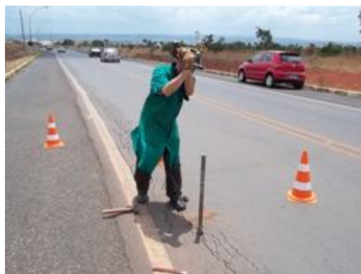
Figura 3.10 – Coleta de umidade natural nas camadas de pavimento (Trecho 2).
