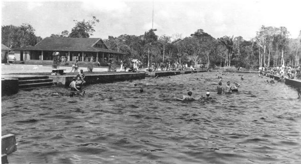
Figura 12: Balneário Parque Dez - Igarapé do Mindu Fonte: IBGE, 1963
