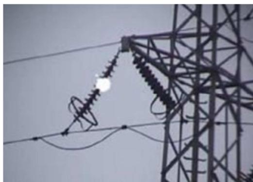
Figura 2.9 – Imagem da formação de descarga do tipo corona em linha de transmissão.
