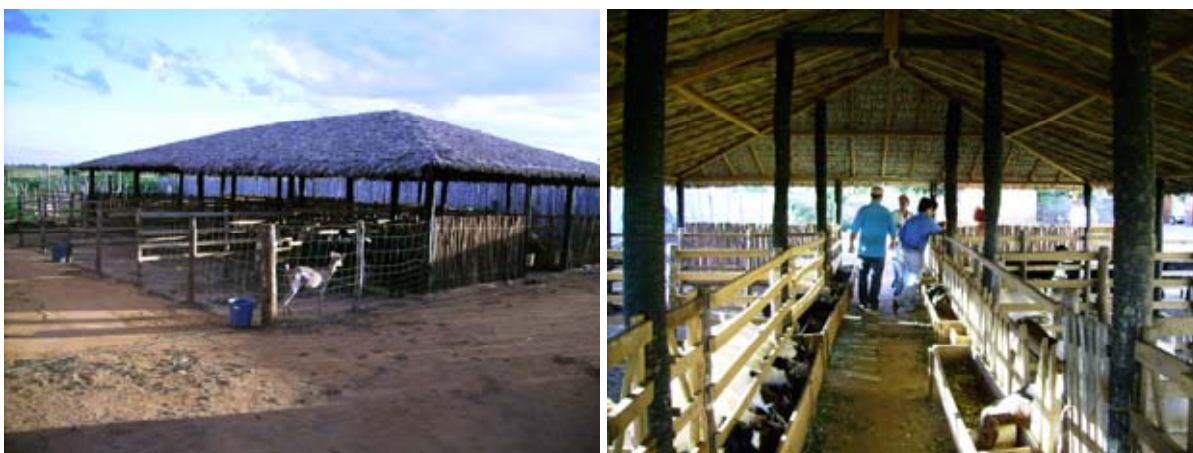
Ilustração 10. Instalações rústicas de um dos condomínios, localizados no entorno da cidade de Jussara.
