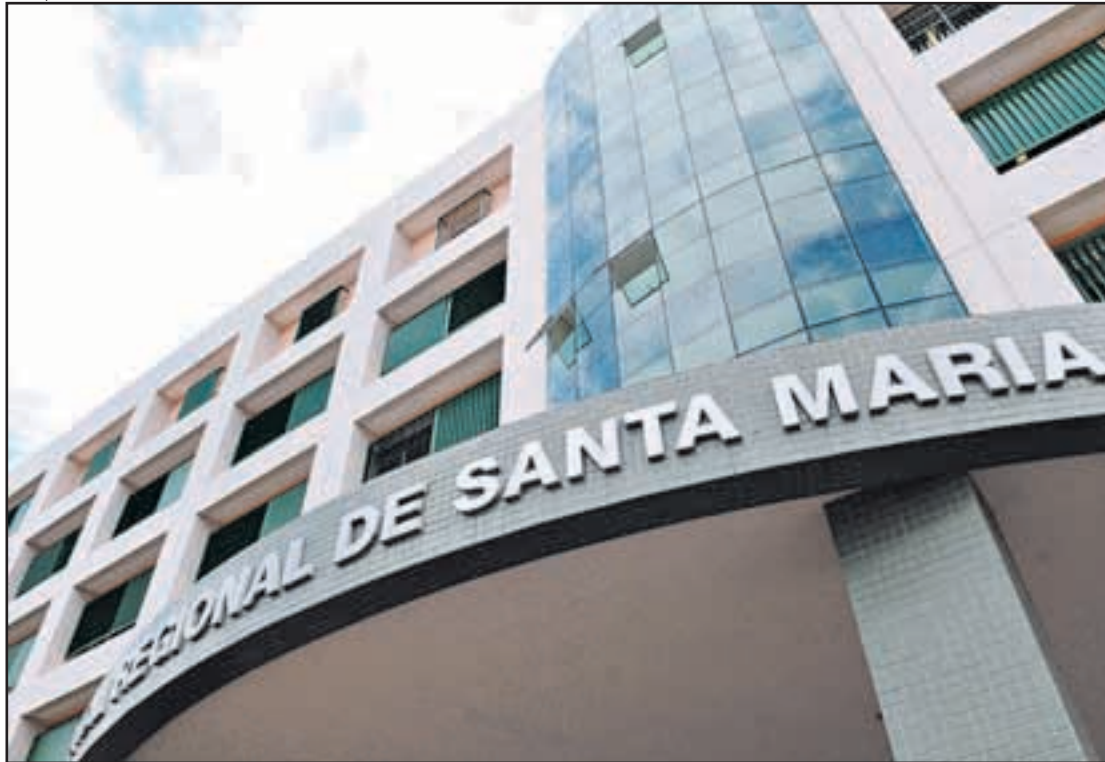
Segundo denúncia, a reforma no sistema de tubulação do leito trocou oxigênio por ar comprimido
