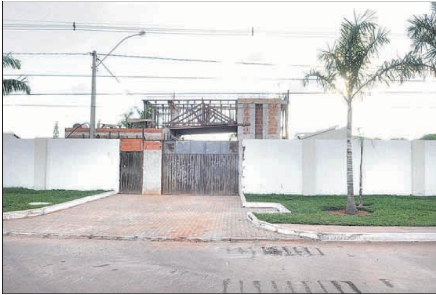
Guarita em construção em Vicente Pires: intenção de empresário era formar um condomínio nobre, com residências que custam, em média, R$ 600 mil
