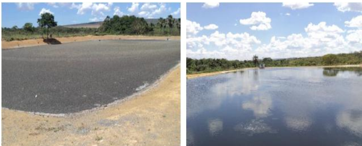
Figura 15 - Lagoa de tratamento da água após a sua utilização no frigorífico.
