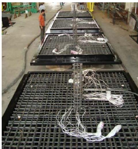
Figura 3.12 – Aspecto final das fôrmas com as armaduras de flexão das lajes
