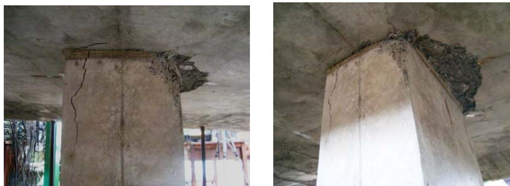
Figura 4.168 – Esmagamento do concreto na superfície inferior da laje LW05.
