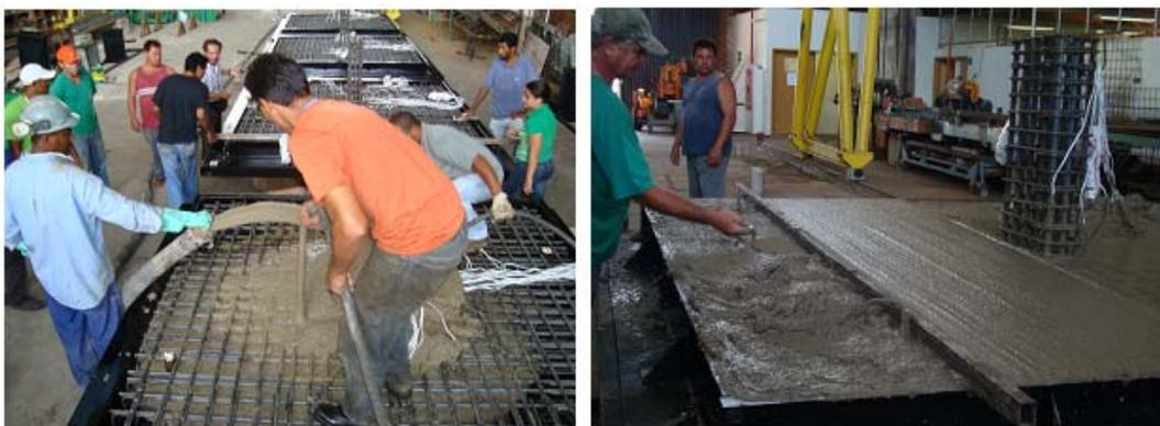
(a) Lançamento e adensamento do concreto. (b) Acabamento da superfície do concreto.
