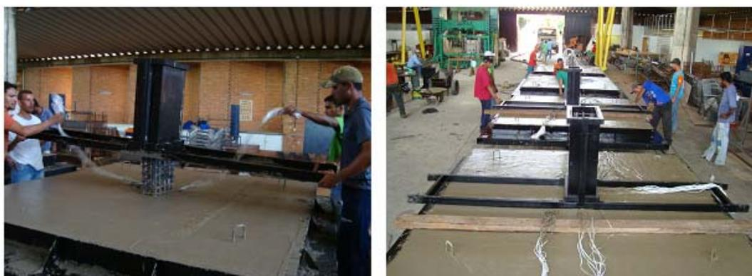
(c) Instalação da fôrma superior do pilar. (d) Acabamento na superfície da laje.
