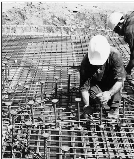
(a) - Montagem da armadura tipo *Stud*
