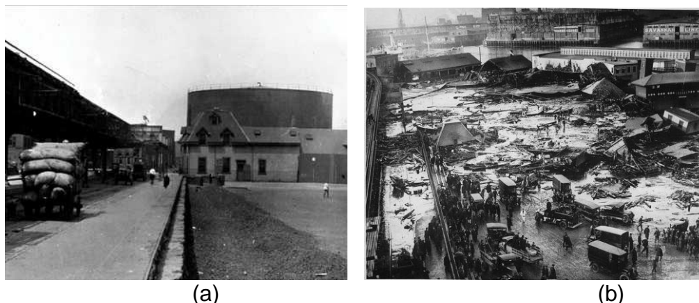
Figura 3.4 - Tanque de armazenagem de melão que se rompeu devido a propagação de um trinca a partir da janela de inspeção: (a) antes ; (b) depois.
