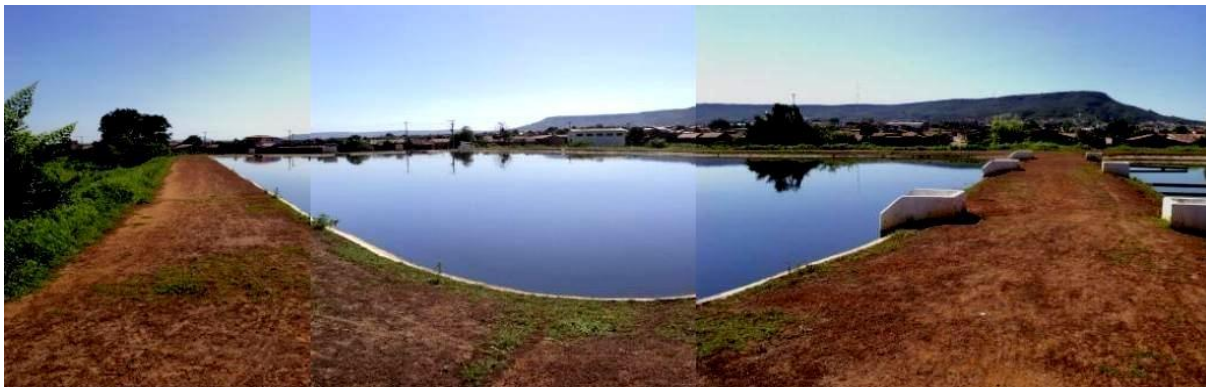
Figura 4.6: Lagoa de tratamento de esgoto no bairro Vila Brasil.
