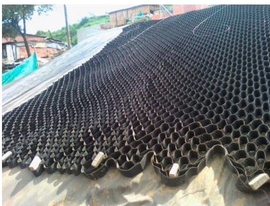
Figura 4.60 Instalação da geocélula sobre a geomembrana no Trecho 2.
