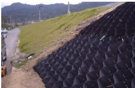
Figura 2.9 Talude íngreme com o uso de geocélulas para estabelecer a vegetação.
