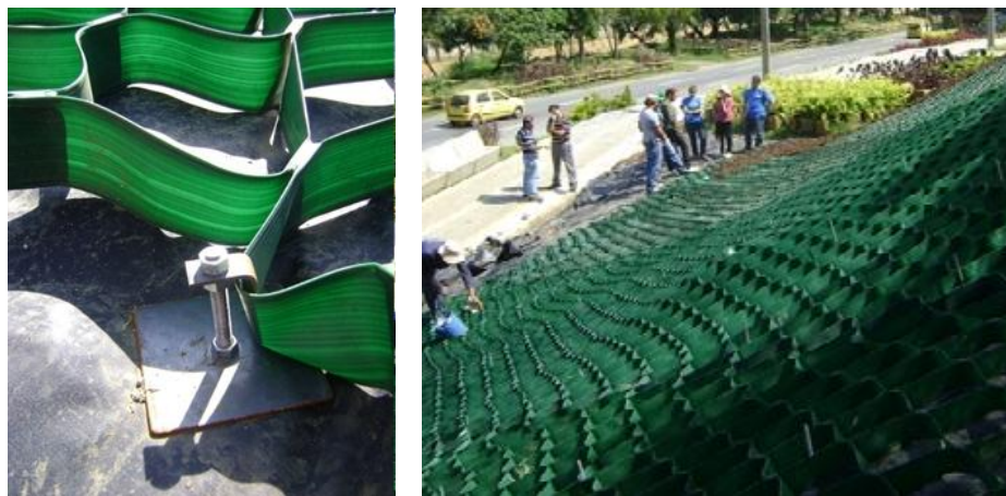
Figura 3.16 Grampo de fixação do sistema geocélula/geomembrana instalado em um trecho experimental do morro. (a) Detalhe do grampo instalado e (b) distribuição de grampos ao longo da geocélula.
