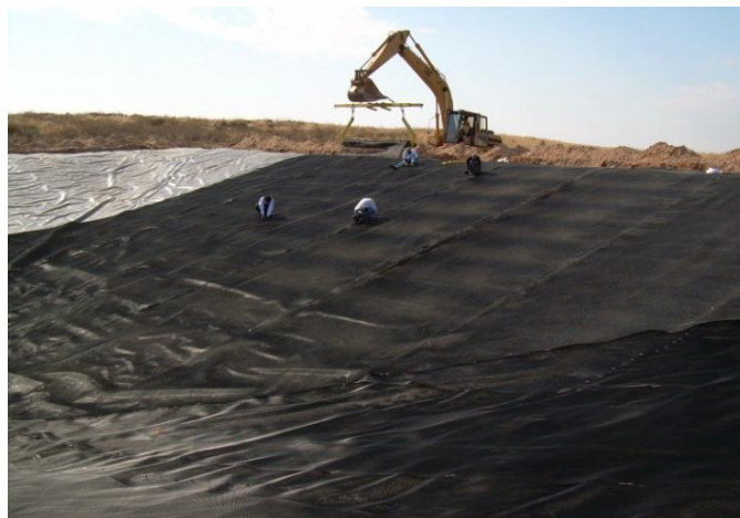
Figura 2.10 Geomembrana como barreira impermeabilizante na construção de aterros sanitários (CAAWS, 2012).
