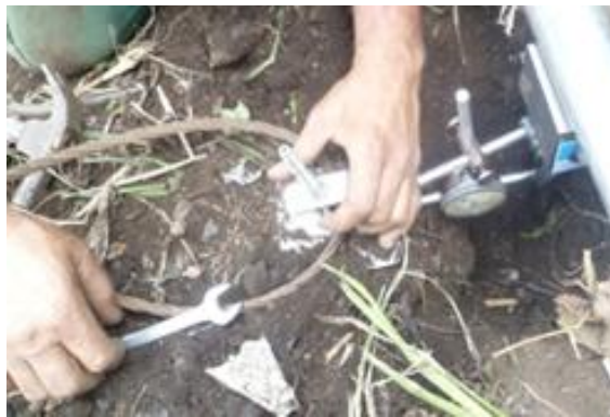
Figura 3.23 Detalhe da instalação do ensaio de carga tangencial em um grampo.
