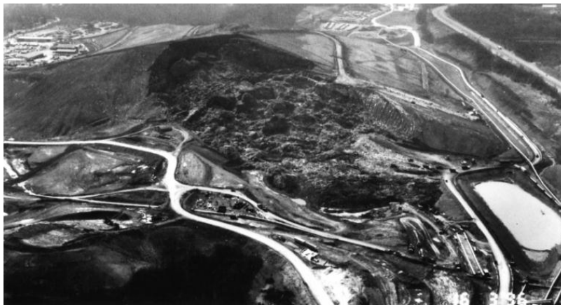
Figura 2.2 Vista aérea do deslizamento no Aterro Sanitário Rumpke nos EUA em 1996 (Eid et al. , 2000).
