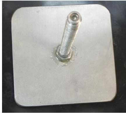
Figura 3.21 Epóxi aplicado entre o grampo e a geomembrana.
