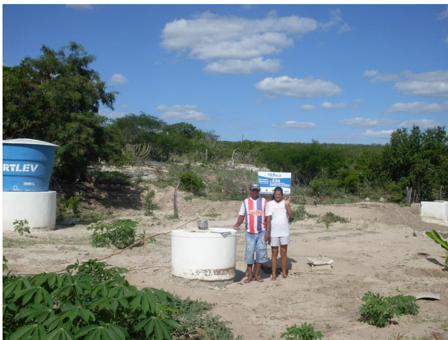
Barragem concluída. Agricultores ao lado do poço, com caixa para irrigação por gravidade à esquerda, placa de identificação da tecnologia ao fundo e plantações recentes de mandioca à frente Foto Arquivo ASACom
