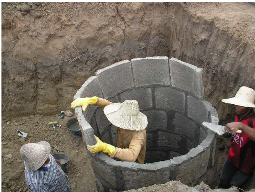
Construção do poço da barragem com placas de cimento Foto Arquivo ASACom
