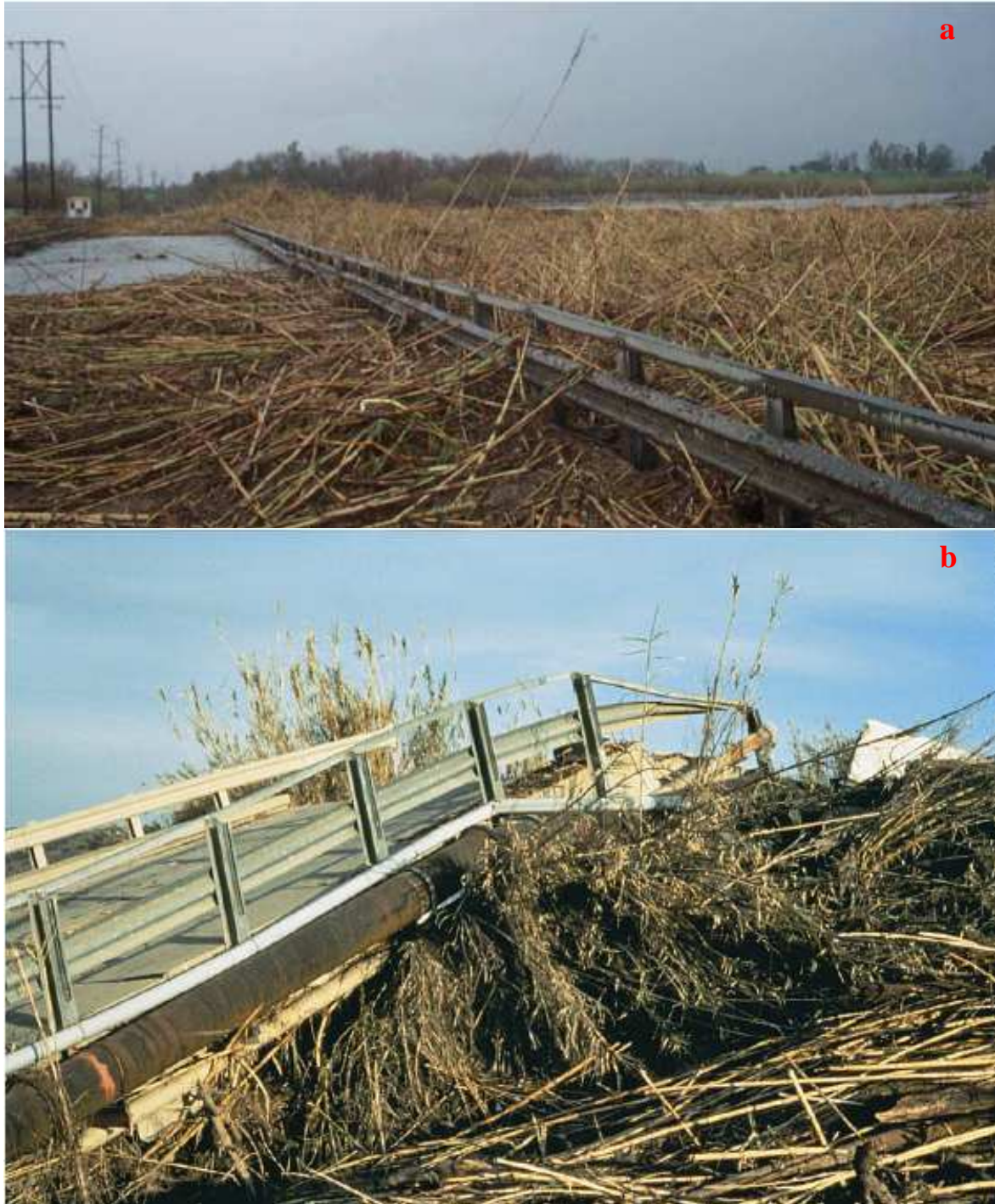
Figura 10. Imagem mostrando a biomassa de Arundo donax empilhada contra a Ponte River Road no rio Santa Ana, após a inundação (a), resultando em um impacto na estrutura da ponte que está sendo empurrada para fora de sua fundação (b). Fonte: Cal-IPC (2011).
