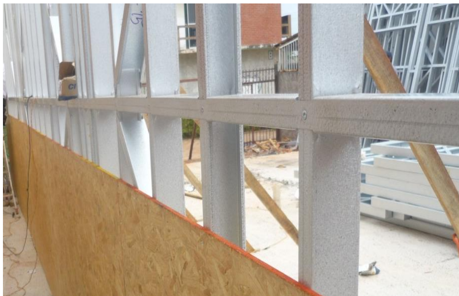
Figura 3.8 - Fixação painéis de OSB.
