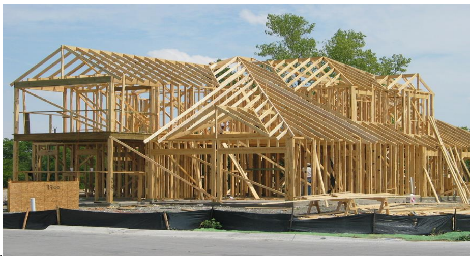
Figura 3.1 - Sistema construtivo LWF. Fonte: STRAND SYSTEM ENGINEER, 2012.
