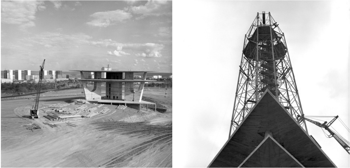
Figura 21 - Montagem da estrutura metálica da Torre. Fonte: ARPDF.
