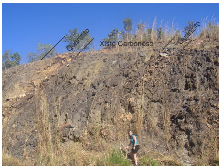
Figura 4.37 - Sucessão quartzito-carbonoso, intercalação de camadas métricas de quartzito com xisto carbonoso. Afloramento na rodovia TO-387 que interliga Paranã-TO a São Salvador-TO.
