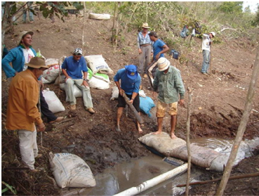
Fotografia 17 – Mutirão para construção de estruturas para abastecimento hídrico na comunidade. Vereda Funda, 2010. Fonte: CAA-NM
