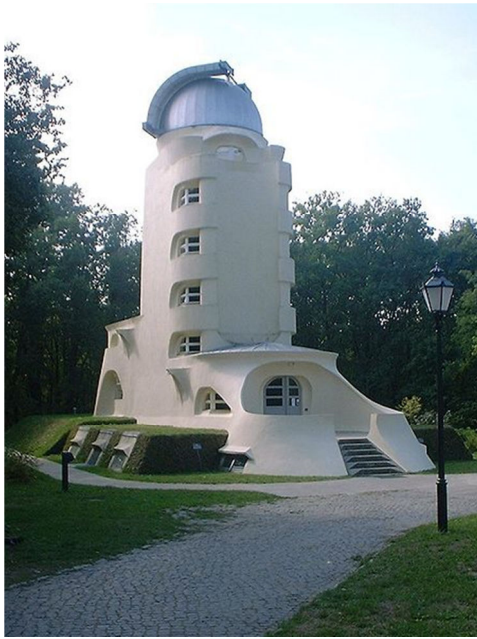
Figura 13. Einsteinurm Tower at Potsdam, Alemanha. Fonte: Fazio, 2008, p. 470.
