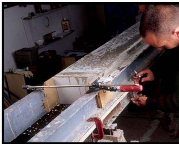
Figura 27: Molde concreto com fibra ótica.
