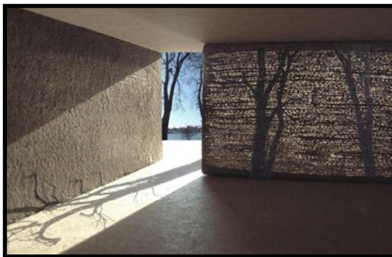
Figura 28: Parede fabricada com painéis de concreto translúcido.
