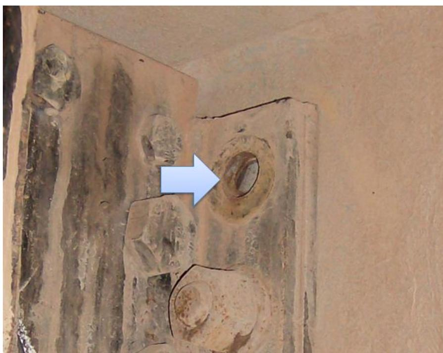
Figura 5.16 – Perda de parafuso por fadiga e fratura final (Miranda, 2010).
