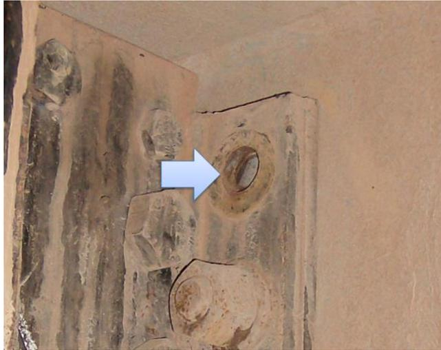
**Figura 1. Perda de parafuso por fadiga e fratura final (Miranda, 2010)**
