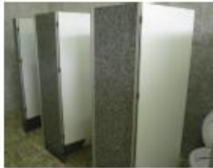
Divisórias no banheiro masculino do bloco construído.
