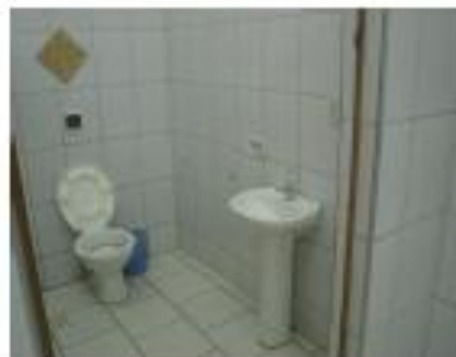
Uma torneira que substituiu a antiga em banheiro masculino do bloco já existente.
