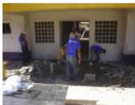
Funcionários com uniforme da Mactel Engenharia Ltda. trabalhando no local.
