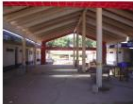
Vista interna da obra de construção da creche.
