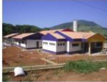
Vista externa da obra de construção da creche.
