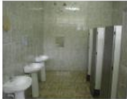
Divisórias e três torneiras no banheiro masculino do bloco construído.
