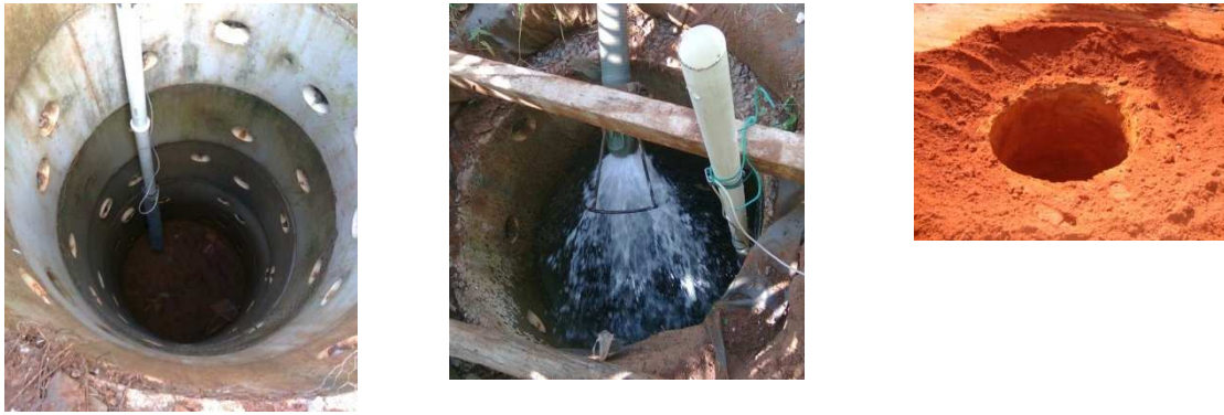
Figura 4.17 – (a) Poço grande diâmetro e em (b) Detalhe do abastecimento mais rápido do poço grande e instrumento de monitoração do N.A. no poço e em (c) poço piloto do CE-II.
