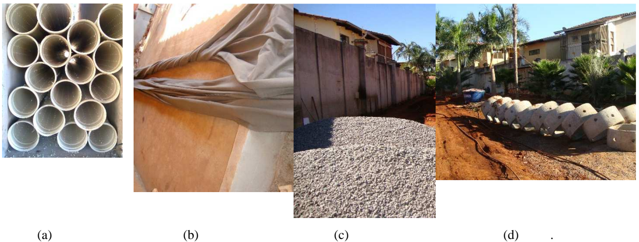
Figura A.5 – Materiais utilizada nos poços e trincheiras: (a) Tubulação drenante; (b) Manta geotêxtil; (c) Brita de preenchimento das trincheiras; (d) Manilha de concreto perfurada para revestimento dos poços de infiltração.
