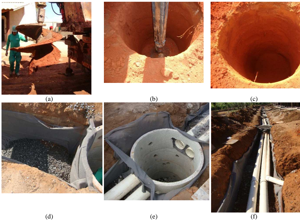
Figura A.6 – Construção mecânica de sistemas de poços e trincheiras: (a) Perfuratriz para poços; (b) processo de escavação do sistema; (c) poço escavado; (d) conexão entre poço e trincheira; (e) vista do poço e trincheira concluídos e; (f) vista do sistema completo com as ligações da tubulação de águas pluviais às unidades habitacional.
