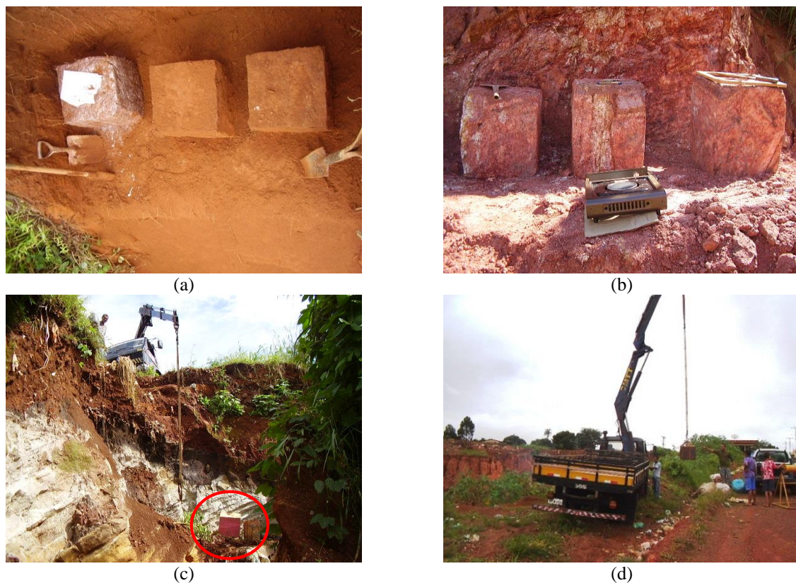
Figura 3.11 - Retirada de amostras indeformadas: (a) Solo altamente intemperizado; (b) Solo saprolítico; (c) Detalhe do bloco de solo dentro da incisão erosiva preparado para ser içado; (d) Bloco de solo sendo içado para dentro da caçamba.
