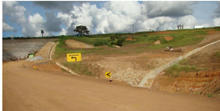
Figura 8.30 - Vista panorâmica da cabeceira de drenagem onde está localizada a voçoroca Túnel.
