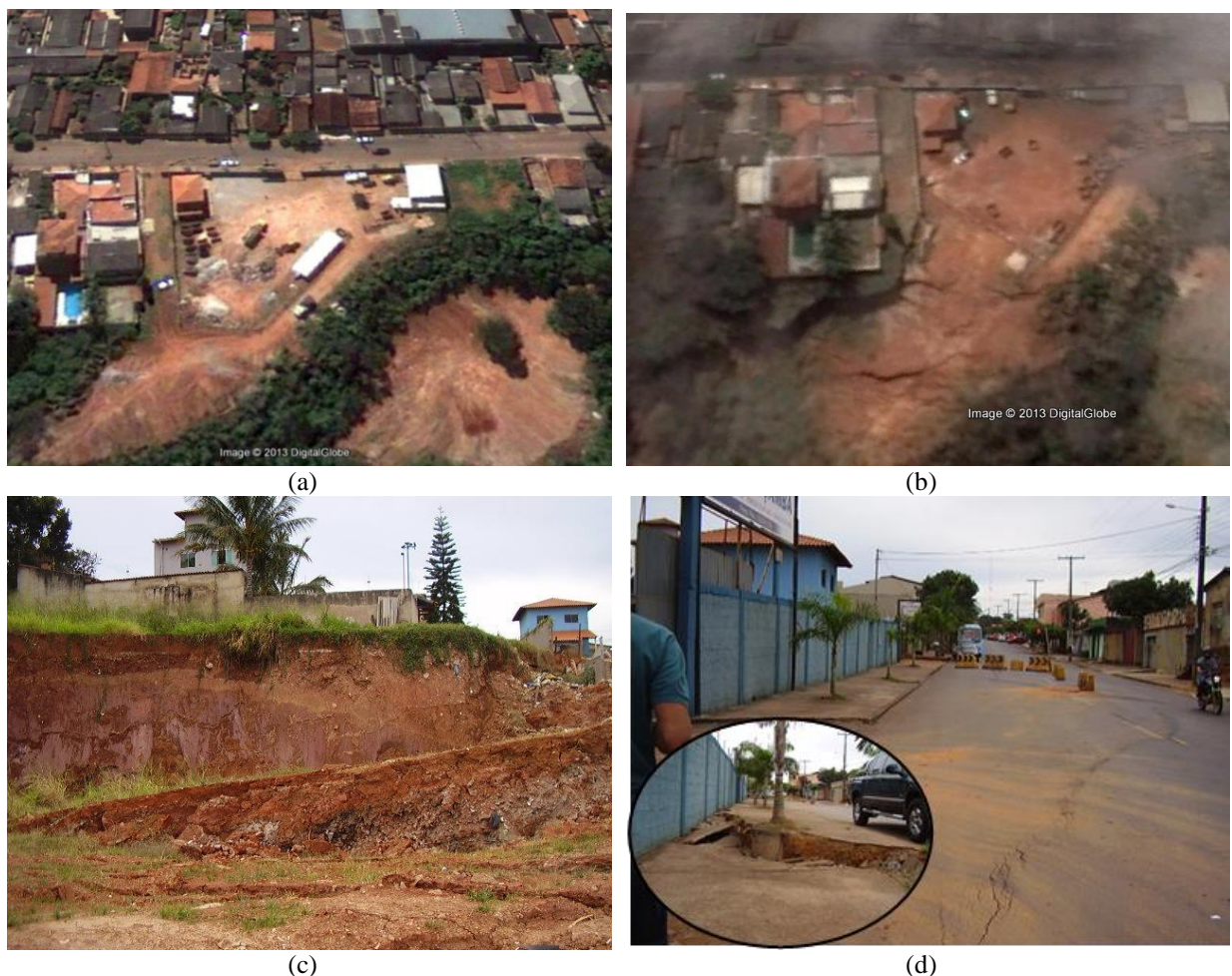
Figura 3.9 - Voçoroca Leopoldo de Bulhões: (a) Vista em planta (Google Earth, 2010b); (b) Vista em planta após ocorrência de escorregamento (Google Earth, 2011); (c) Cicatriz de escorregamento; (d) Avenida Leopoldo de bulhões, parcialmente interditada com recalque. No detalhe recalque na calçada.
