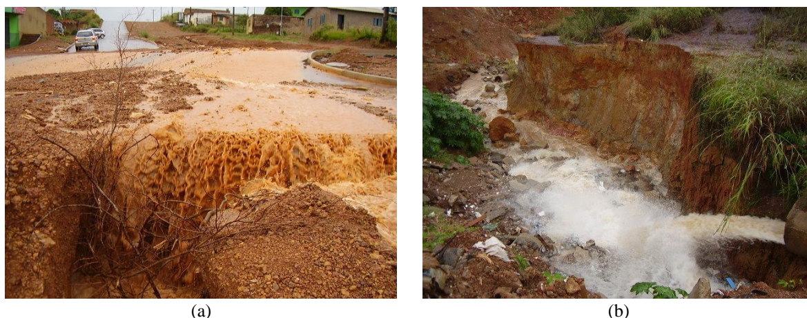
Figura 2.6 - Sistemas inadequados de drenagem de águas pluviais em Anápolis-GO: (a) Rua desprovida de sistema de microdrenagem; (b) Lançamento irregular de águas pluviais em cabeceira de drenagem.
