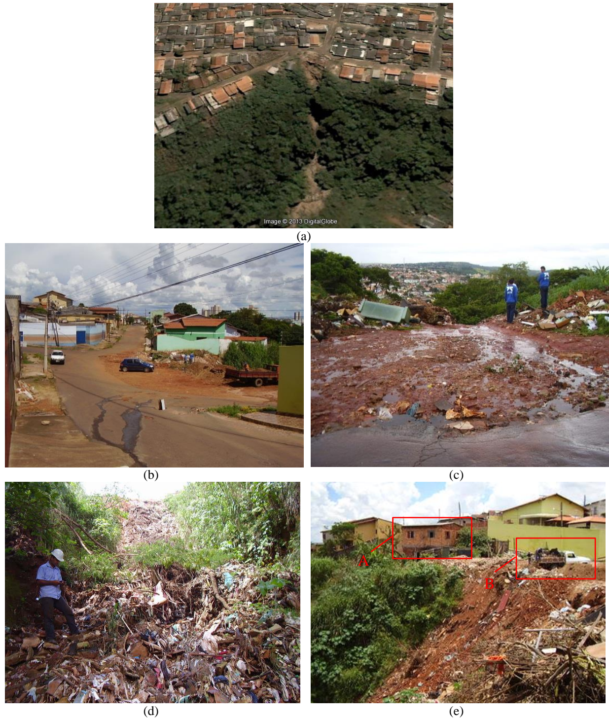
Figura 3.10 - Voçoroca Frei Eustáquio: (a) Vista em planta (Google Earth, 2005d); (b) Relevo côncavo a montante da voçoroca; (c) Escoamento de água concentrado na cabeceira; (d) Vista de jusante para montante, onde é possível observar grande quantidade de lixo e entulho; (e) Borda da voçoroca onde o detalhe A revela uma casa em risco e o detalhe B mostra um carro fazendo lançamento indevido de entulho.
