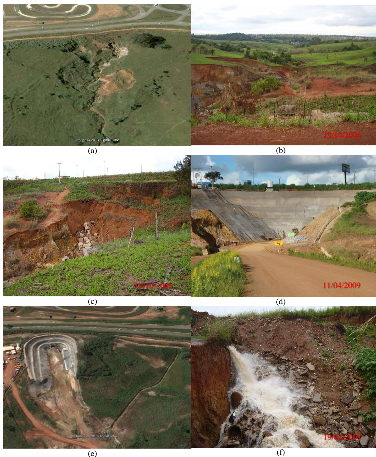
Figura 3.4 - Voçoroca Túnel: (a) Vista em planta (Google Earth, 2005a); (b) Vista longitudinal de montante para jusante; (c) Vista de montante evidenciando canalização de lançamento de águas pluviais; (d) Vista da cabeceira em anfiteatro onde foi construída a obra do emboque 2 do Túnel 2 da Ferrovia Norte/Sul; (e) Vista em planta da cabeceira de drenagem com o túnel a esquerda e a área degradada pela voçoroca, recuperada, à direita (Google Earth, 2010a); (f) Registro de lançamento concentrado de águas na cabeceira de drenagem no momento de uma chuva;
