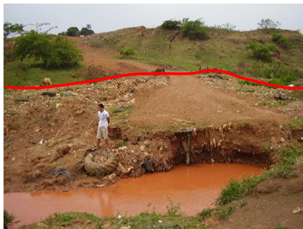
Figura 8.32 - Recuperação da voçoroca Contorno: Vista de jusante para montante.
