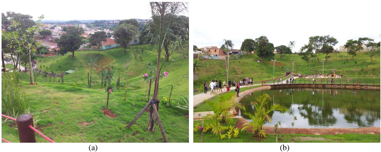
Figura 8.28 - Recuperação de erosão no município de Anápolis: (a) Vista de montante para jusante; (b) Vista de jusante para montante.
