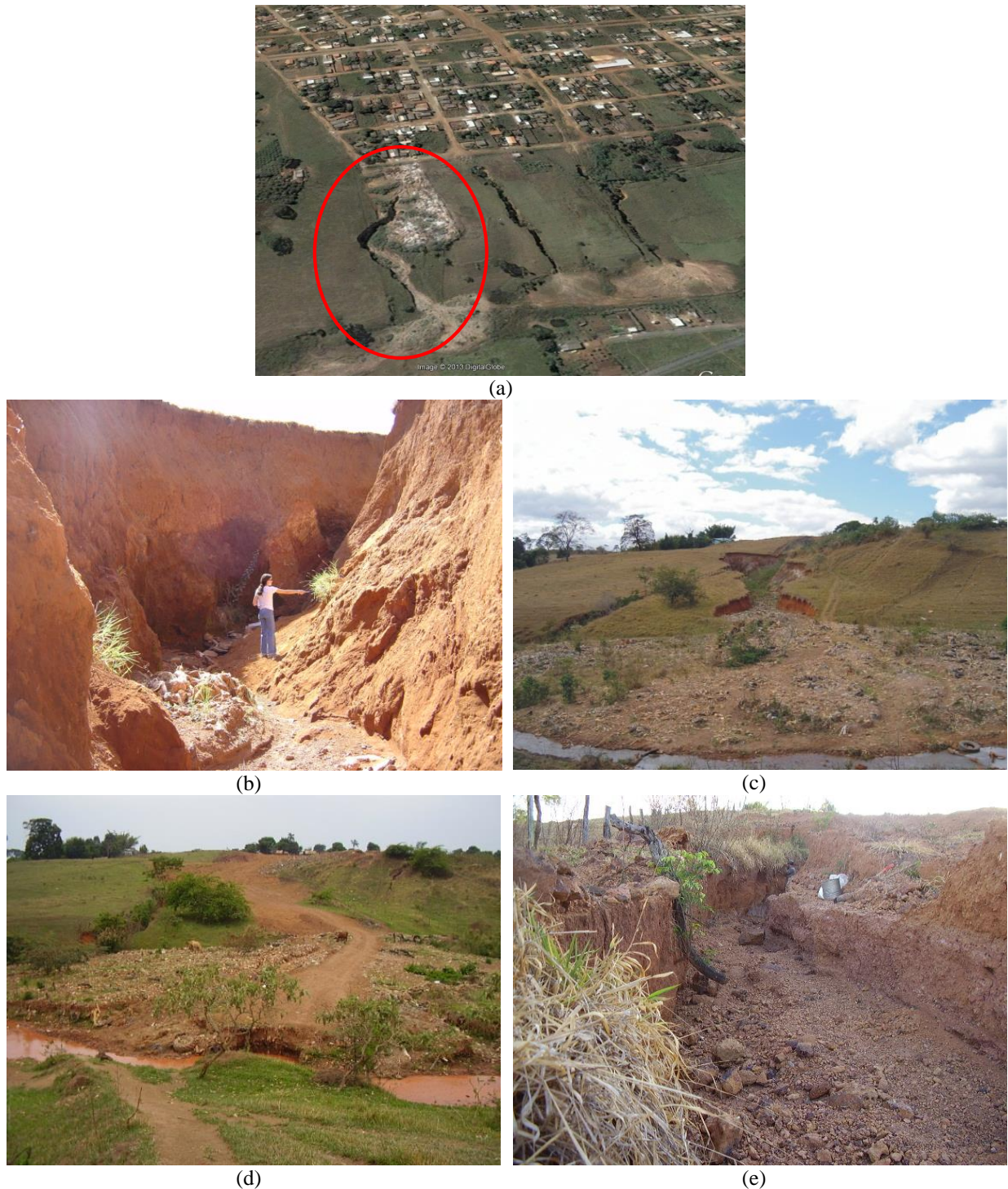
Figura 3.5 - Voçoroca Contorno: (a) Vista em planta (Google Earth, 2005b); (b) Vista do interior da voçoroca; (c) Vista longitudinal de jusante para montante evidenciando cone de dejeção em primeiro plano; (d) Erosão aterrada sem os devidos cuidados de remoção do material que compunha o cone de dejeção que colmatava a drenagem; (e) Ravina que se instalou sobre o aterro da voçoroca.
