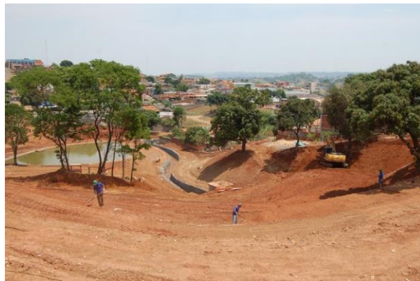
Figura 8.29 - Execução da obra de recuperação da voçoroca da avenida Getulino Artiaga em Anápolis (Anápolis, 2008b).
