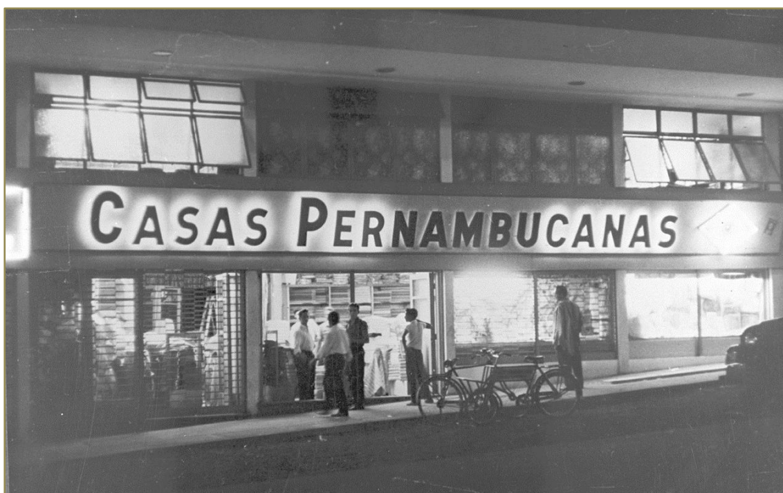
Figura 54: Casas Pernambucanas, instaladas no bloco D da CLS 108 em 1960. Autor desconhecido. Fonte: ArPDF .
