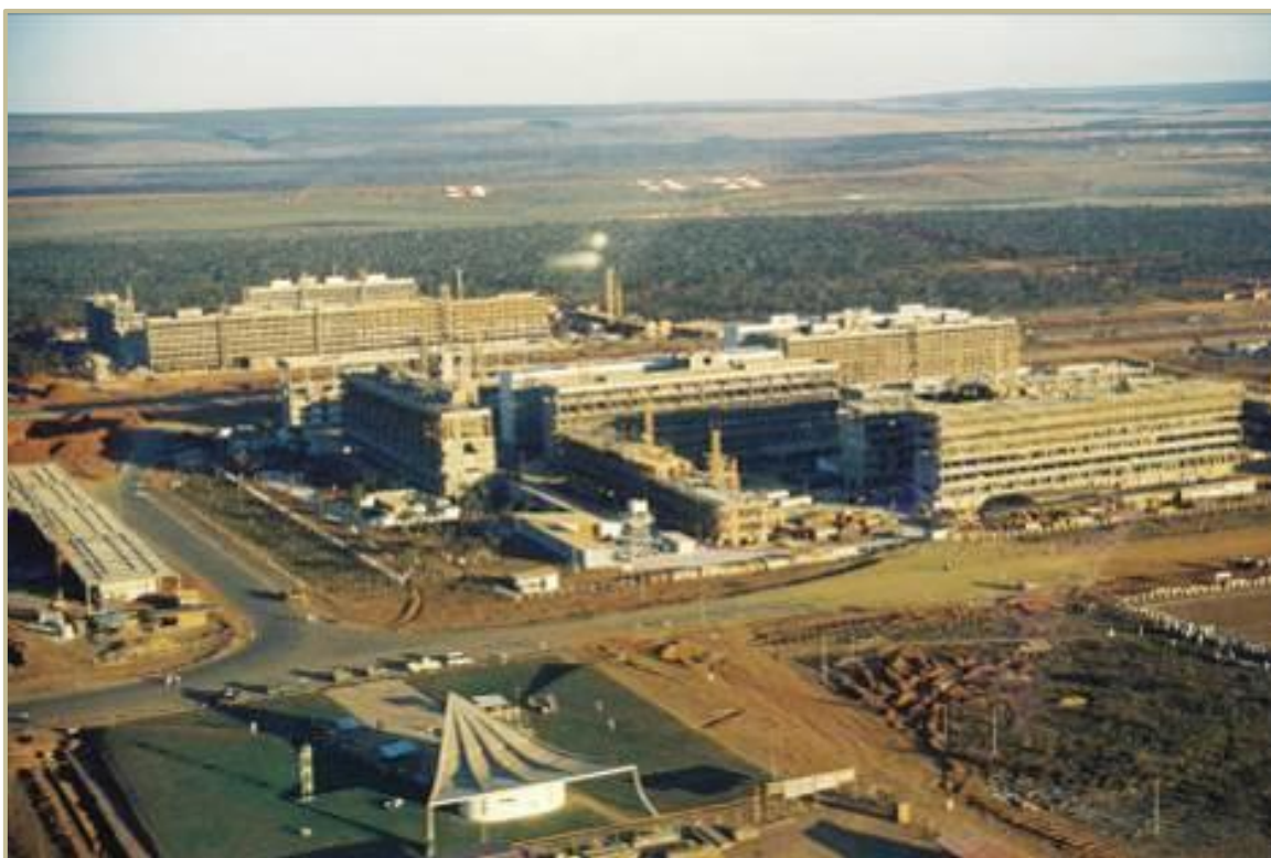
Figura 28: Igrejinha de Fátima construída, tendo à direita as obras da SQS 108. O comércio local da 107 já se encontrava em construção, e o da 108 ainda estava nas fundações. Autor desconhecido. Fonte: ArPDF.
