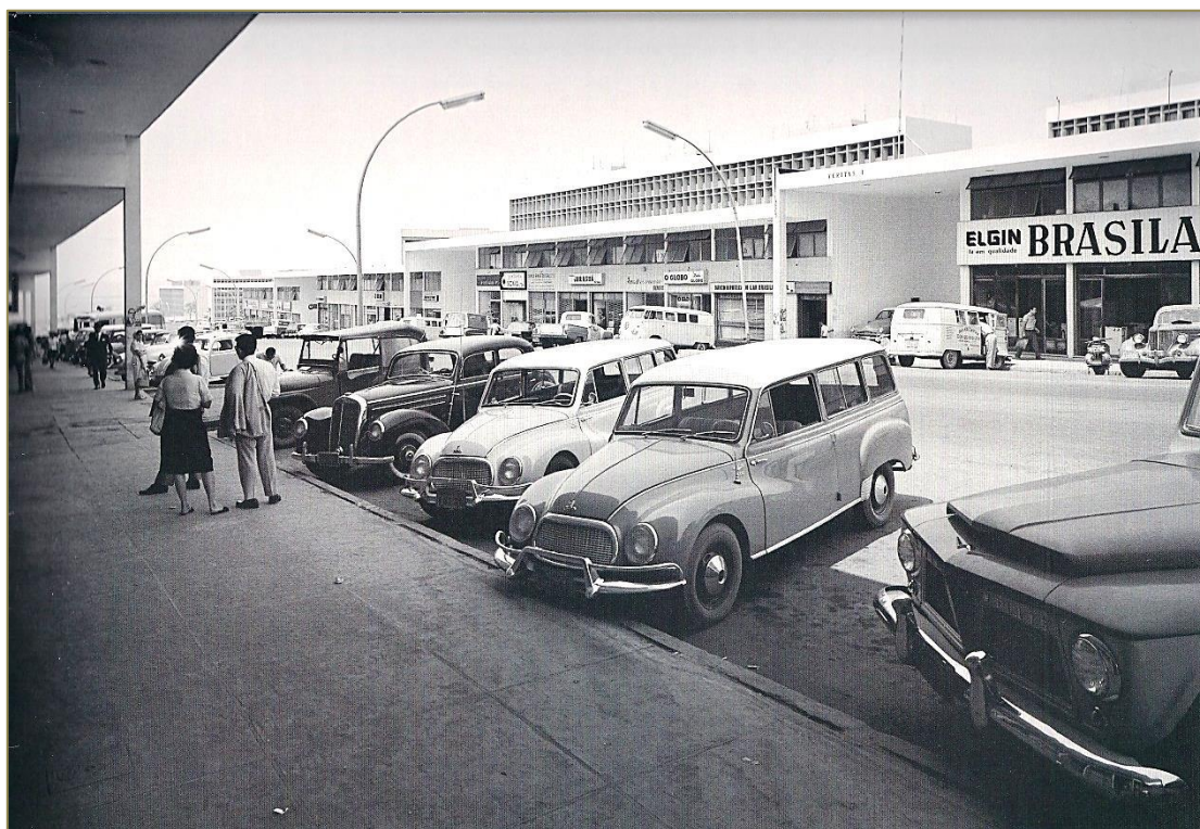
Figura 61: Aspecto da Rua da Igrejinha nos primeiros anos de existência (sem data). Autor não identificado. Fonte: Acervo Instituto Moreira Salles (apud KIM; WISELY, 2010, p. 375).
