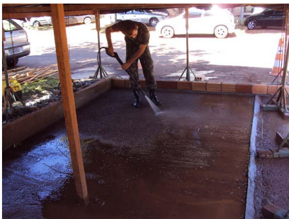
Figura 4.34 – Limpeza do pavimento
