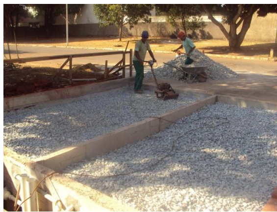
Figura 4.21 – Acomodação da brita
