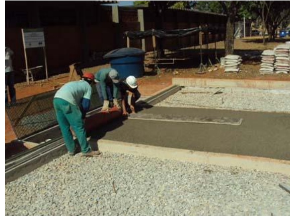
Figura 4.23 – Rolagem do concreto
