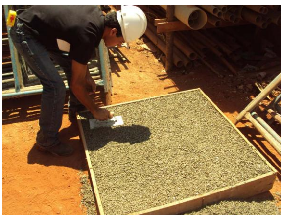
Figura 4.14 – Acabamento da superfície
