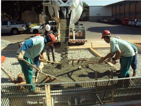
Figura 4.22 – Lançamento e espalhamento do concreto
