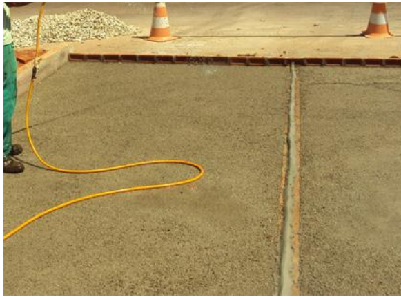
Figura C9 – Barreira físicas, lateral e final da vaga
