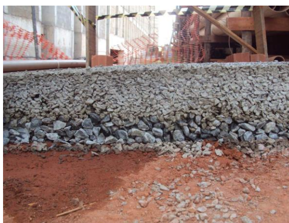
Figura 4.15 – Concreto desformado
