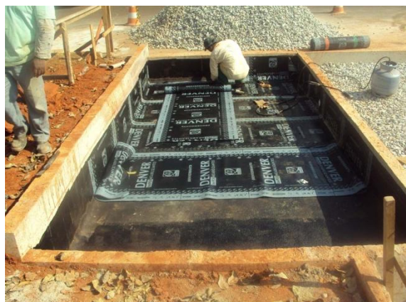
Figura 4.17 – Impermeabilização
