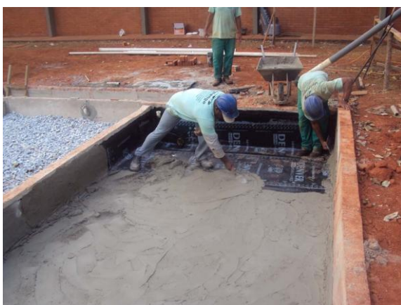
Figura 4.18 – Proteção mecânica
