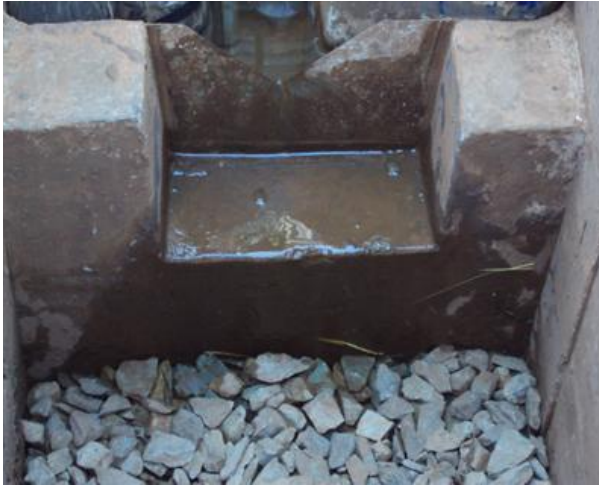
Figura 4.26 – Vertedor triangular
