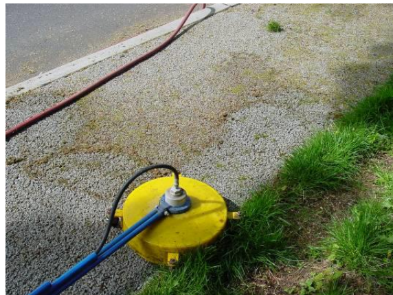
Figura 3.17 – Varredura com bomba de vácuo
