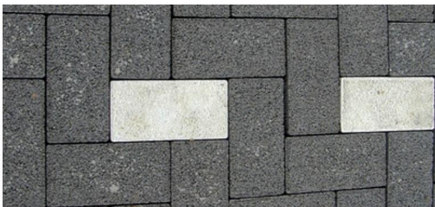
Figura 3.14 – Pavimentação em blocos pré moldados de concreto poroso
