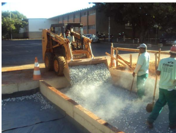
Figura 4.20 – Lançamento da brita
