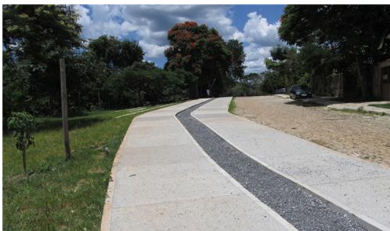
Figura 3.13 – Calçada em concreto permeável em Pirenópolis, GO
