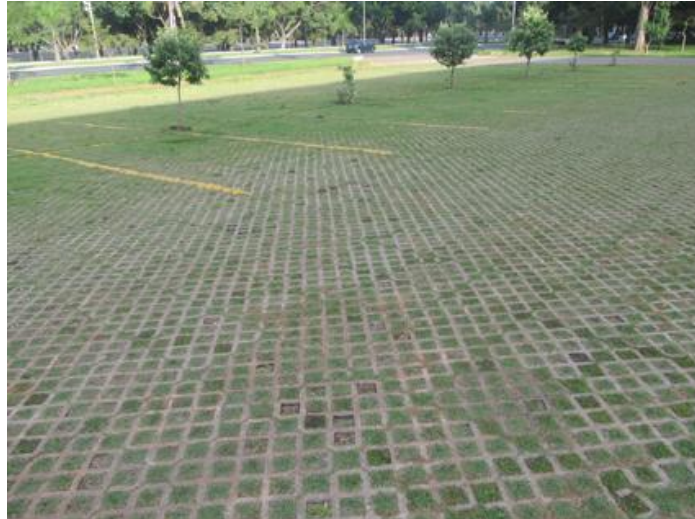
Figura 3.11 – Aplicação de blocos vazados de concreto
