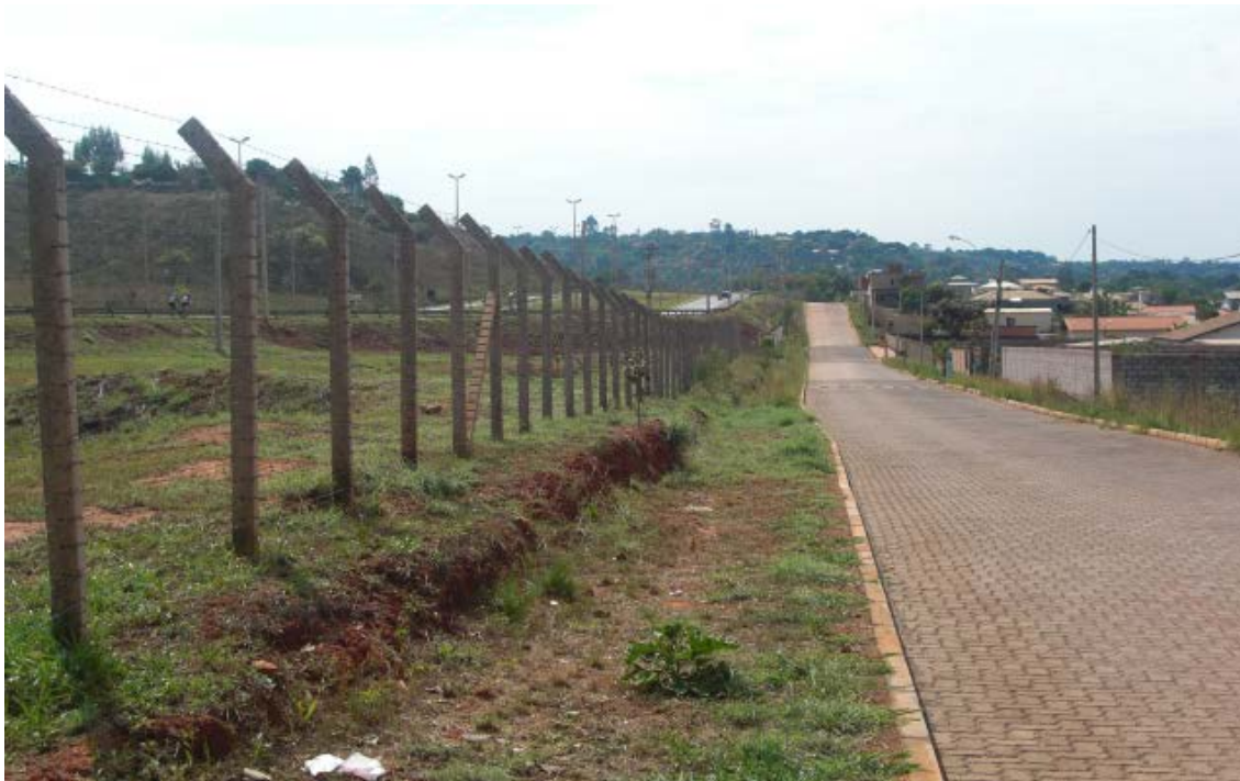
Figura 2.1 - Vista interna de um condomínio, indicando via principal paralela à via externa, separadas entre si por cerca de arame. Ausência de conexão entre as vias e impedimento de acesso interno ao condomínio.
