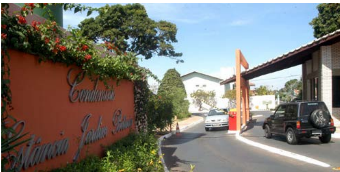
Figura 2.2 - Guarita de entrada e muros de cercamento – Fonte: www.clicbrasil.com.br
