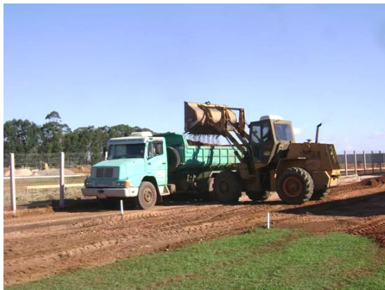
Figura 5.8 - Transporte do material de corte.
