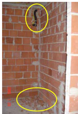
Figura 2.2 - Detalhe de RCD gerado durante a execução de uma etapa da obra.
