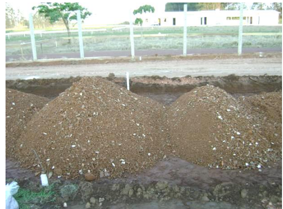
Figura 5.13 - Mistura de solo-RCD espalhada sobre o subleito.
