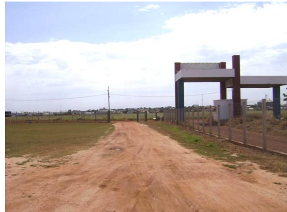
Figura 5.3 - Detalhe do local em que foi executado o trecho experimental.
