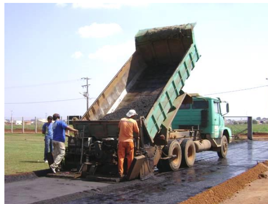
Figura 5.17 - Aplicação do PMF utilizando um dispositivo vibroacabador.
