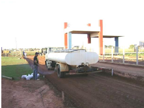
Figura 5.12 - Detalhe do caminhão pipa lançando água no subleito.
