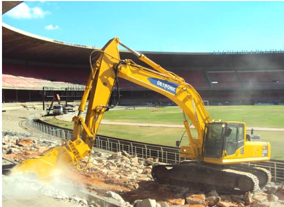
Figura 1.1 - Demolição do Estádio Fonte Nova - Salvador - BA. (FONTE: SPACES, 2011)
