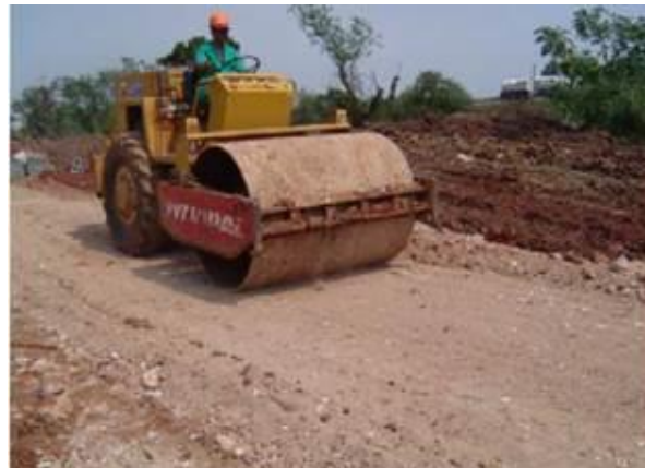
Figura 2.8 - Compactação da camada de agregado reciclado - USP-Leste.
