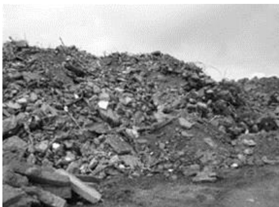
Figura 2.13 - Entulho gerado pela demolição do estádio Mané Garrincha - Brasília - DF.
