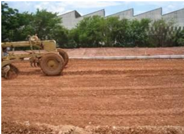
Figura 2.7 - Motoniveladora espalhando o agregado reciclado - USP-Leste.
