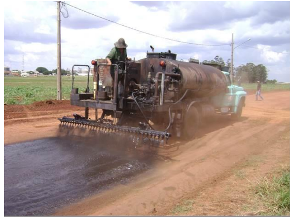
Figura 5.29 - Aplicação do ligante sobre a bandeja para medição da taxa.
