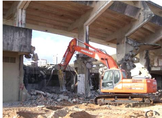
Figura 1.2 - Demolição do Estádio Machado - Natal - RN. (FONTE: AUGUSTO, 2011)
