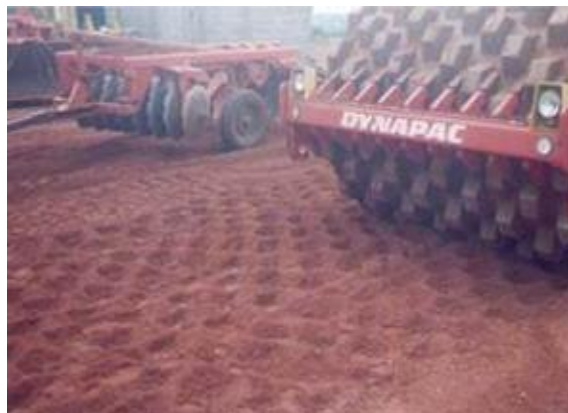
Figura 2.10 - Detalhe do rolo pé-de-carneiro compactando a camada de sub-base.
