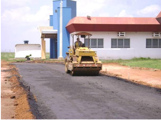
Figura 5.18 - Detalhe da compactação realizada com o rolo liso.
