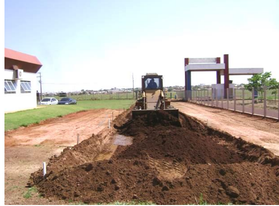
Figura 5.7 - Remoção da camada superficial.
