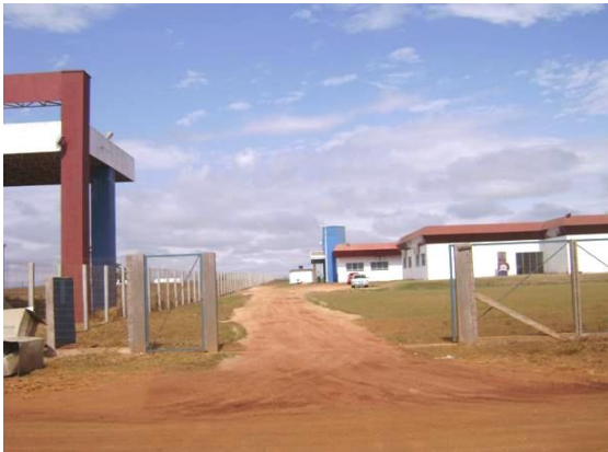
Figura 5.2 - Vista geral ilustrando o acesso ao trecho experimental.
