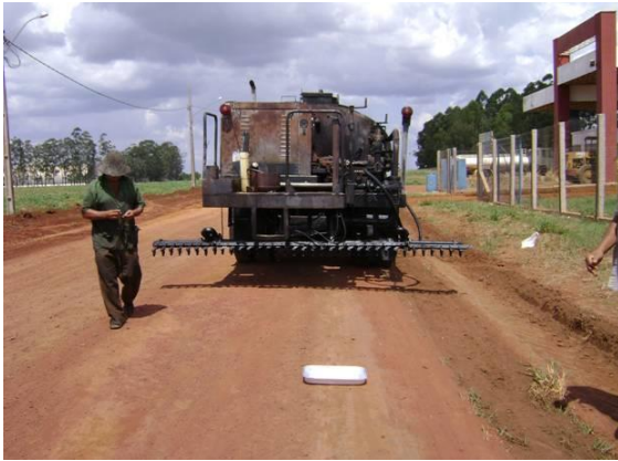
Figura 5.28 - Detalhe da preparação do ensaio do controle da taxa de ligante.
