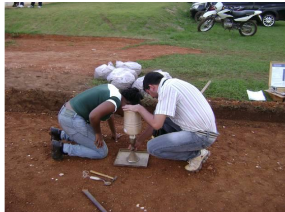
Figura 5.23 - Detalhe do controle da compactação na camada de base.
