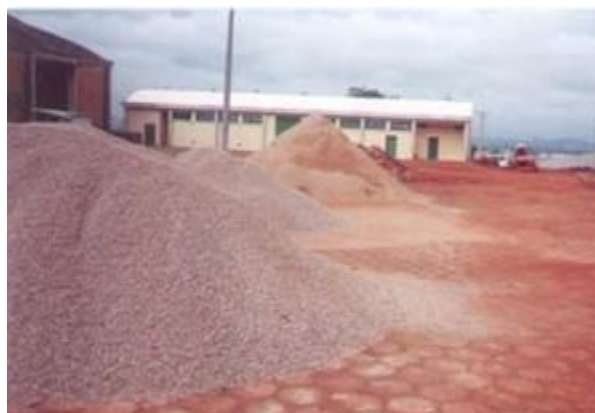
Figura 2.9 - Pilhas dos agregados reciclados de RCD utilizados nas camadas do trecho.
