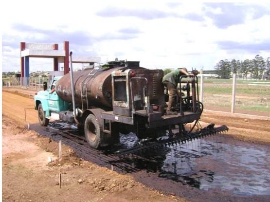
Figura 5.14 - Detalhe da aplicação do CM-30 - Imprimação asfáltica.
