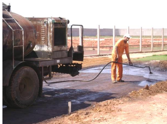
Figura 5.15 - Início da aplicação da emulsão RR-2C - Pintura de ligação.
