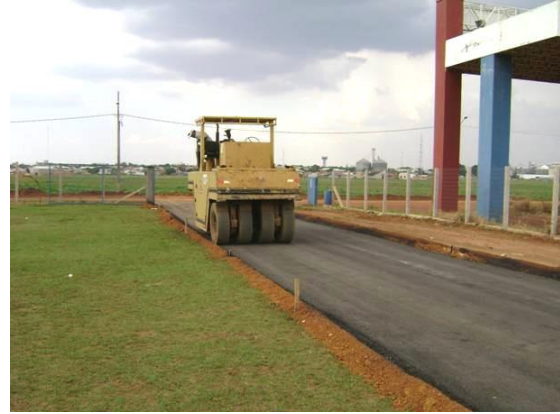
Figura 5.19 - Detalhe da compactação realizada com o rolo pneumático.
