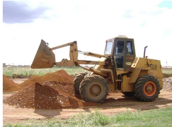
Figura 5.11 - Mistura em pista do solo e RCD.
