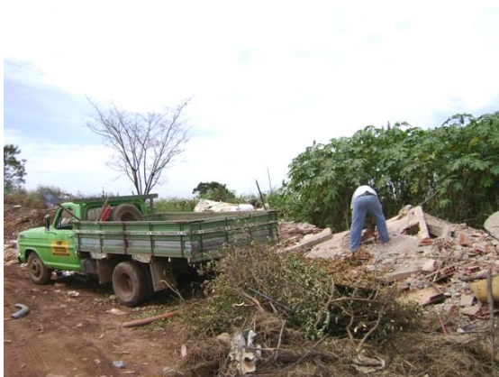
Figura 3.3 - Triagem realizada em campo para os RCD em estudo.
