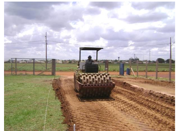
Figura 5.9 - Compactação da camada de regularização do subleito.
