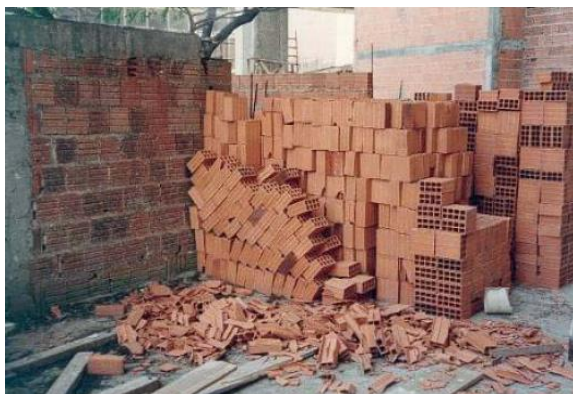
Figura 2.1 - RCD gerado por falhas no armazenamento de blocos cerâmicos.
