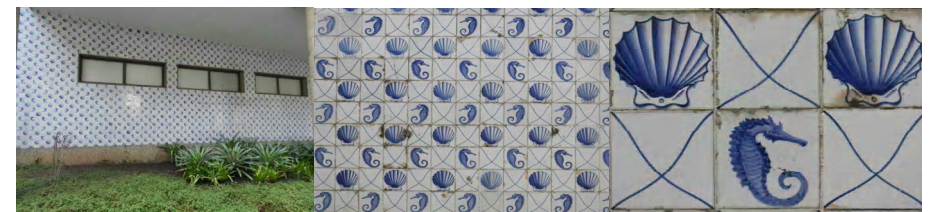
Figura 19 Painel de azulejos, revestimento externo das paredes do auditório. Fotografias, Elizabeth Ervatti Rocha de Lima, 2012.
