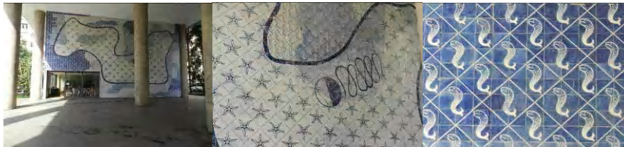
Figura 20 Painel de azulejos, revestimento externo das paredes da Livraria. Fotografias, Elizabeth Ervatti Rocha de Lima, 2012.
