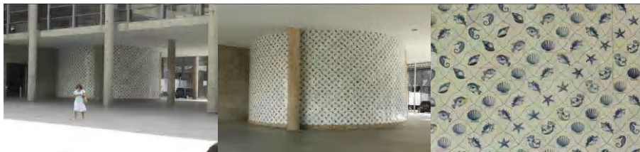
Figura 21 Painel de azulejos, revestimento externo da parede da escada. Fotografias, Elizabeth Ervatti Rocha de Lima, 2012.
