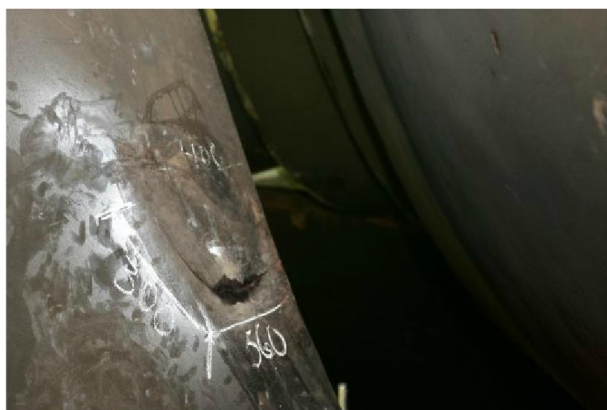
Figura 1: Turbina danificada da Usina Hidrelétrica de ITAIPU [3].
