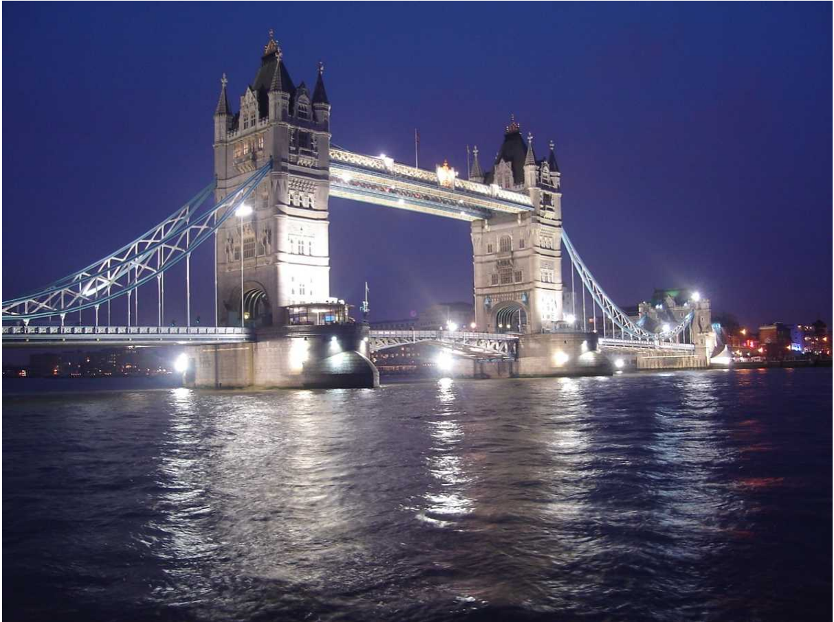
Figura 2.7 – Vista noturna da Ponte da Torre de Londres (Inglaterra), executada entre 1886 e 1894, com clara influência da arquitetura gótica. Segundo JONES e WOODWARD (2000, p. 291), “como a maioria das tradições britânicas, é uma invenção Vitoriana”: uma arquitetura para representar a imponência do imperialismo inglês.
