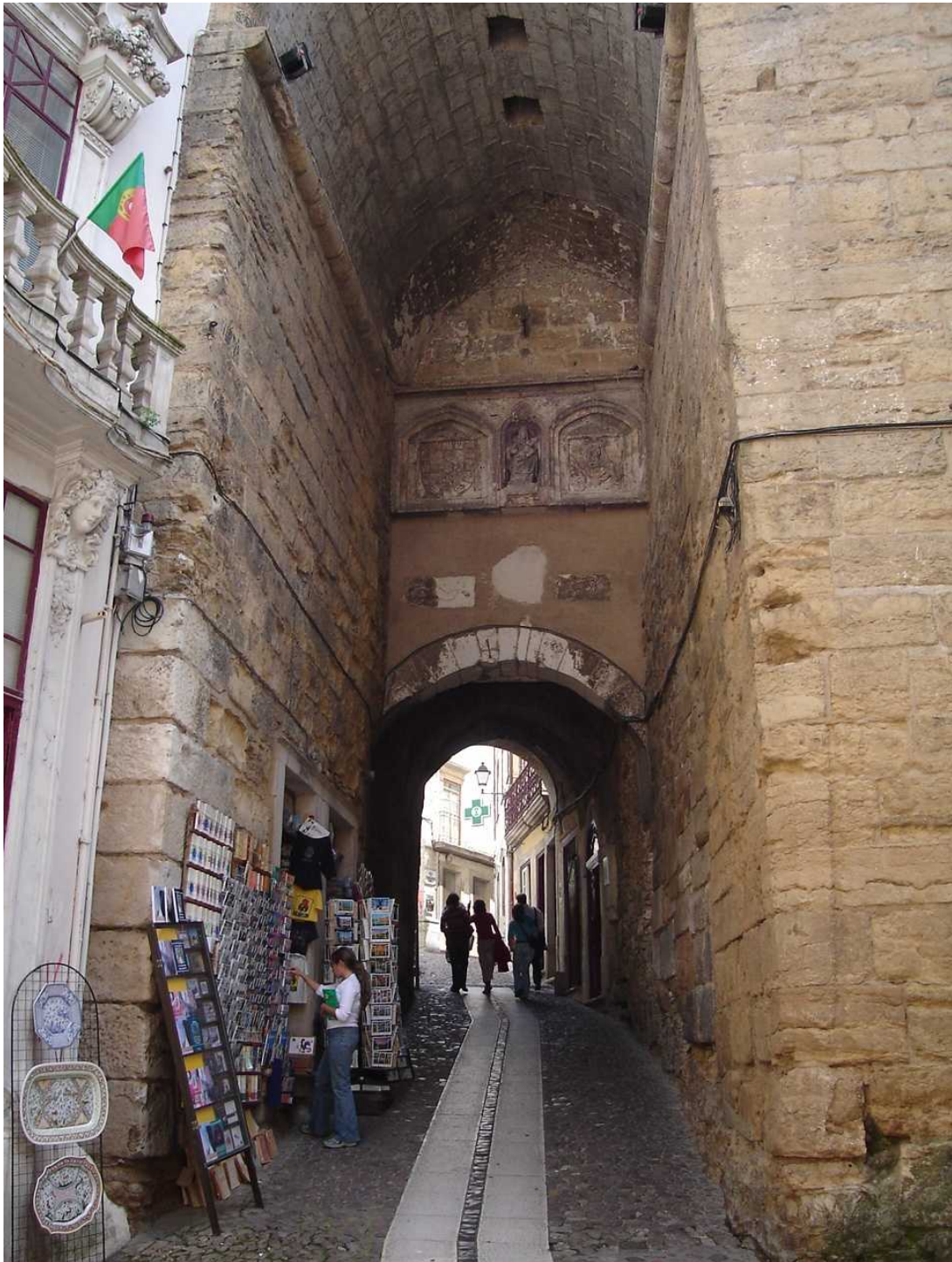
Figura 3.51 – Arcadas edificadas sobre ruelas que conduzem à cidade alta em Coimbra – Portugal: a forma-espaco adensada é vestígio medieval e influência direta do saber fazer árabe. À direita desta posição o Arco de Almedina demarca o antigo acesso para a cidade antiga.
