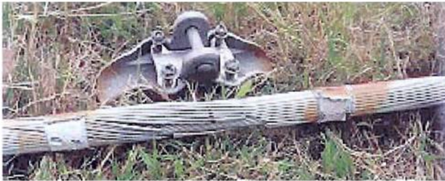
Figura 1.1 - Falha por fadiga em sela de fixação (SNEGOVSKI, 2004).
