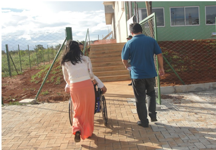
Fotografia 02- entrada câmpus Gama , bloco B, sala de aulas.
