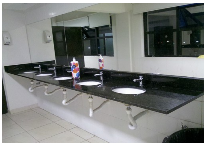
Fotografia 13 – banheiro feminino, bloco sala de aulas, câmpus Taguatinga.
