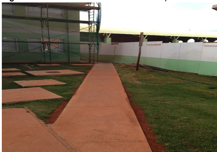
Fotografia 11 - acesso às salas de aula no câmpus Samambaia
