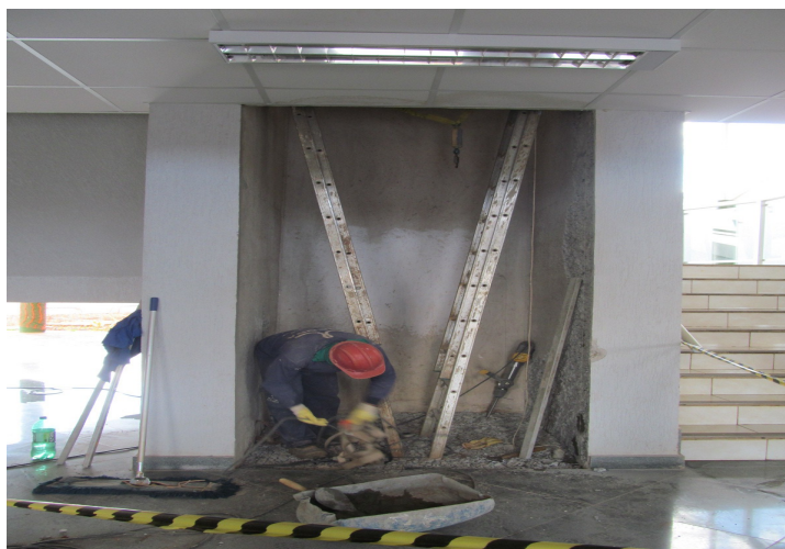
Fotografia 03 - elevador em construção câmpus Gama, bloco A, prédio administrativo
