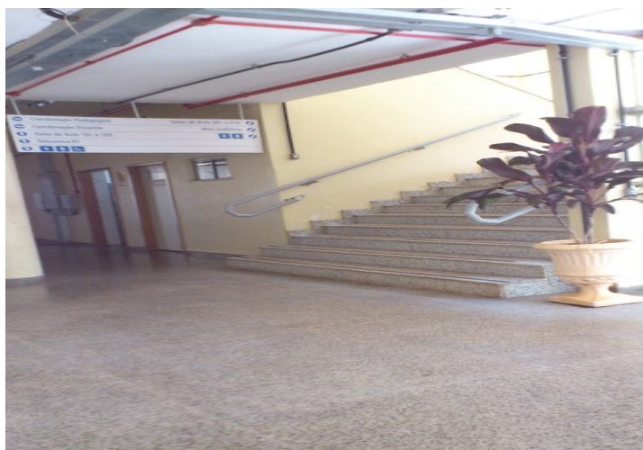
Fotografia 05- acesso às salas de aula no câmpus Planaltina.
