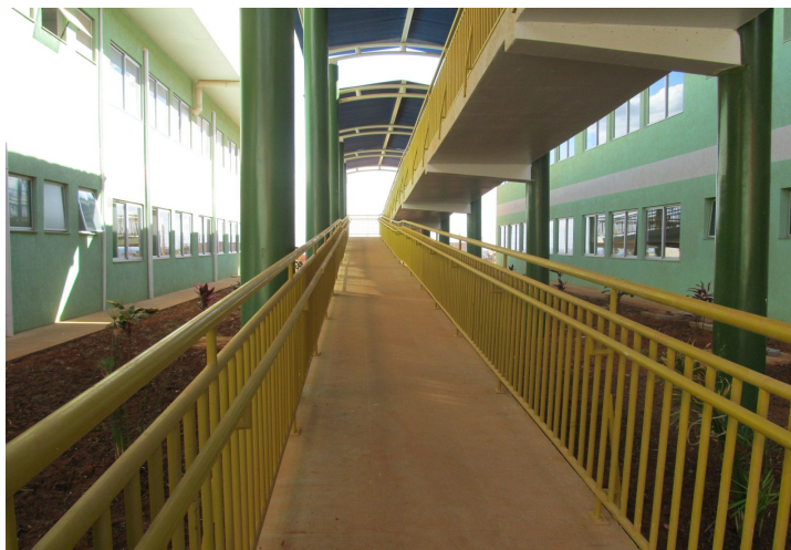
Fotografia 01 - rampa câmpus Gama, bloco B, sala de aulas.
