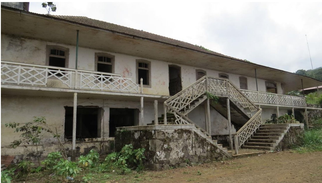
Foto 18, Ruínas da Roça Monte Café, JATOBÁ & CAIXETA, 2013
